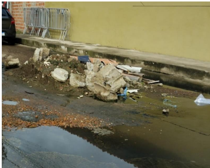
Figura 3 - Resíduos de Construção Civil interferindo no sistema de drenagem
