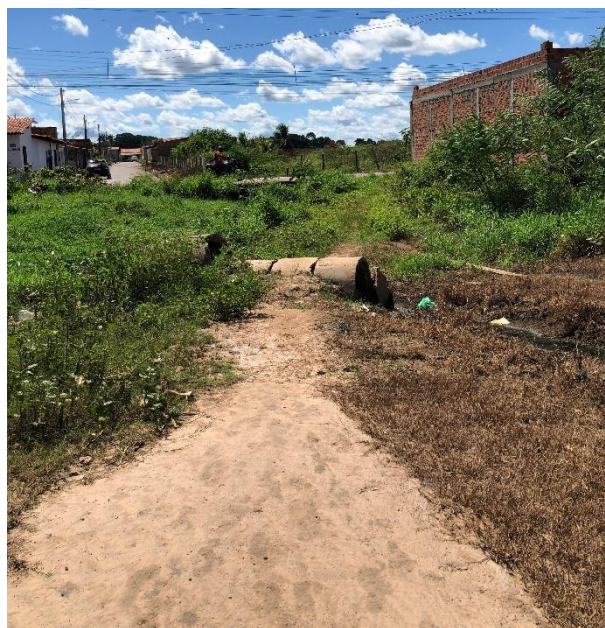
Figura 16: Trecho sem presença de sarjetas e com vegetação cobrindo a lateral da rua
