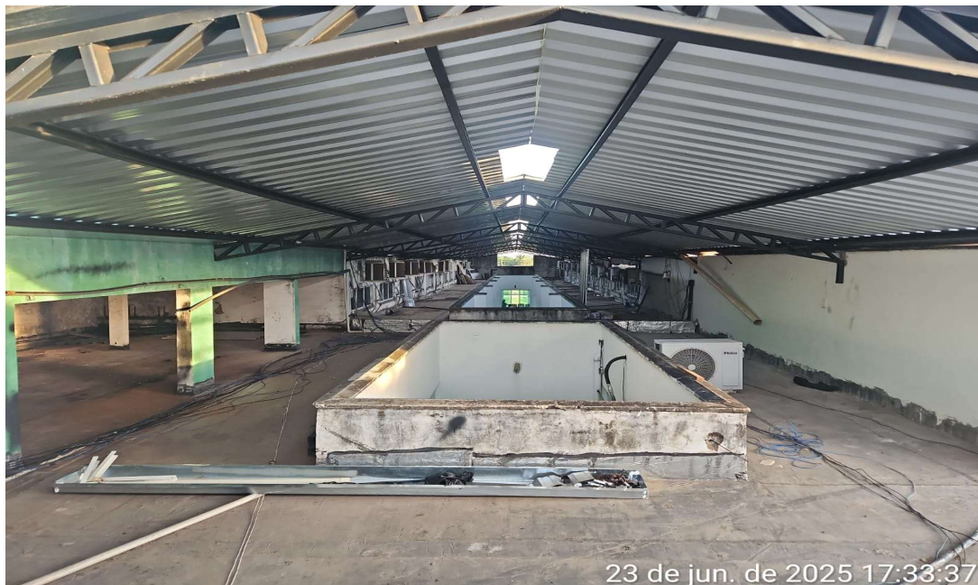
Figura 11: Cobertura metálica sobre laje.
