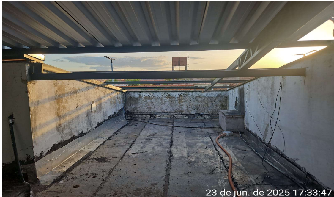
Figura 12: Cobertura metálica não finalizada.
