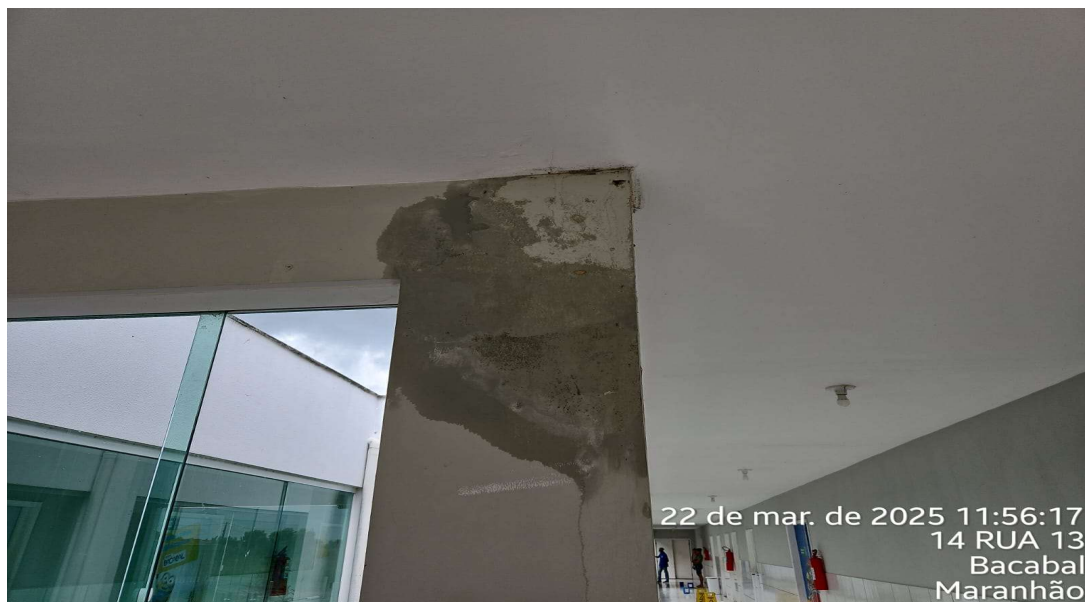
Figura 9: Percolação no teto e mofo nas paredes.
