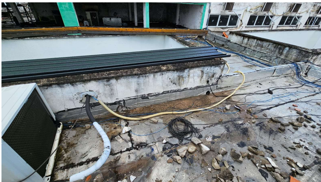
Figura 6: Manta asfáltica aluminizada aplicada sobre a laje 1.
