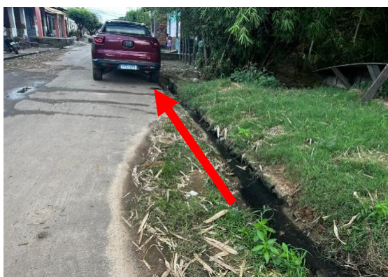
Imagem 4 – Destinação de esgoto em sarjeta destruída, poluída e sem tratamento do bairro Trizidela, no Rio Mearim.
