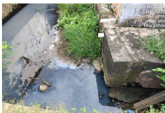
Imagem 2 – Exemplo de despejo inadequado de esgoto doméstico em Bacabal – MA
