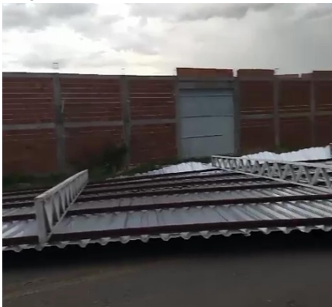
Figura 01 - Vento derruba estrutura metálica de galpão e interrompe trânsito na BA-120, entre Castro Alves e Santa Terezinha no Estado da Bahia.
