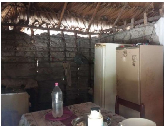
Figura 25: Casa de taipa com telhado feito de palha e madeira de tronco.
