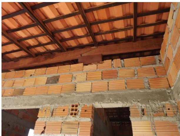
Figura 48: Detalhe da cobertura com pedaços de madeiramento improvisados
