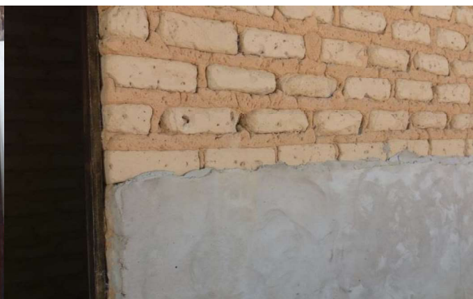
Figura 26: Casa feita de tijolo de adobe, parcialmente revestida.
