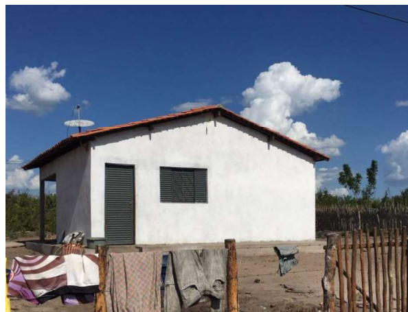
Figura 49: Fachada da casa com mão de cal e esquadrias metálicas
