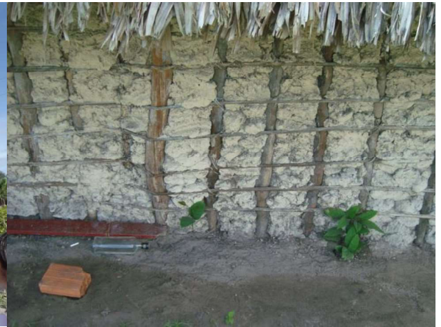
Figura 74: Método construtivo taipa de mão aplicado em casa do povoado
