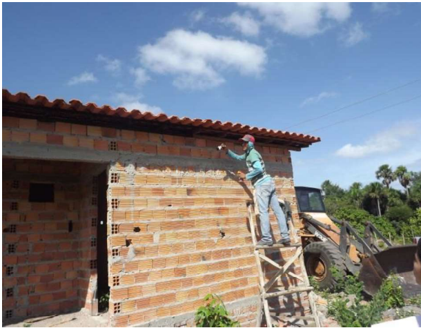
Figura 73: Conclusão da cobertura em casa de alvenaria cerâmica
