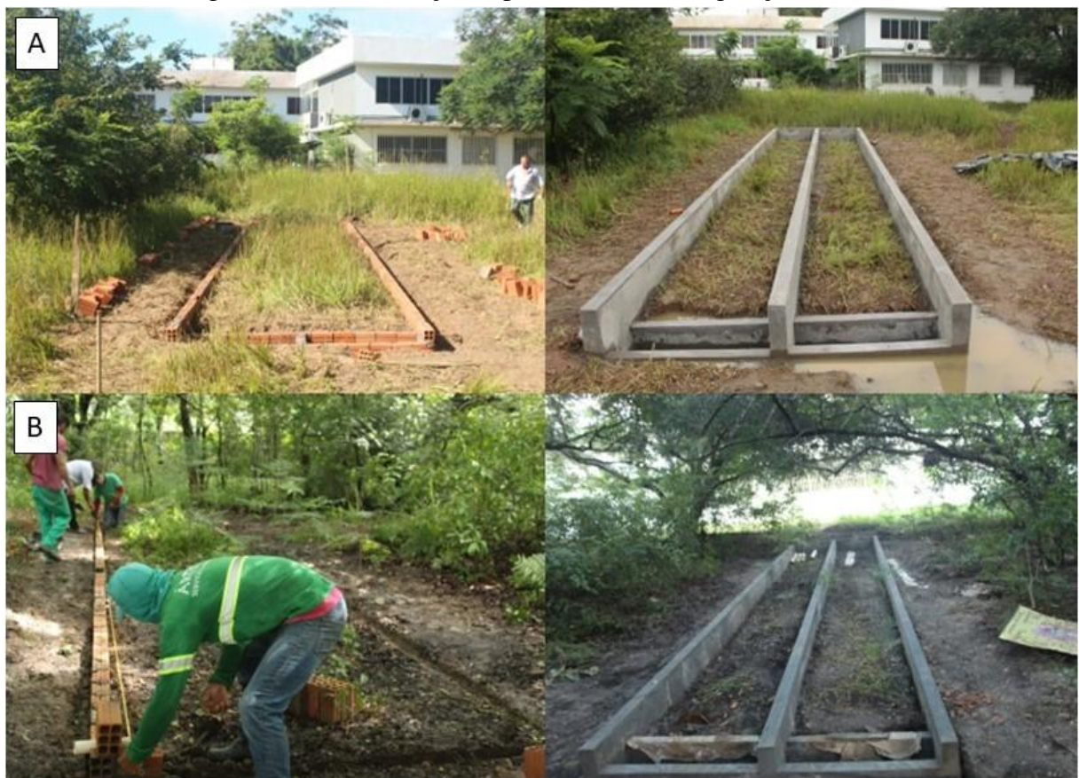
Figura 8: Construção das estações experimentais (A – estação experimental com vegetação de gramíneas; B – estação experimental com vegetação arbórea).
