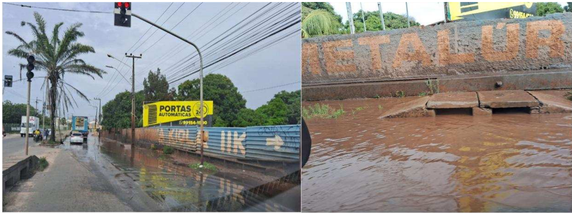
Figura 25 – Ponto 2 (ficha de alagamento)
