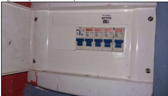
Figura 9- QDG sem sinalização em uma residência da Liberdade
