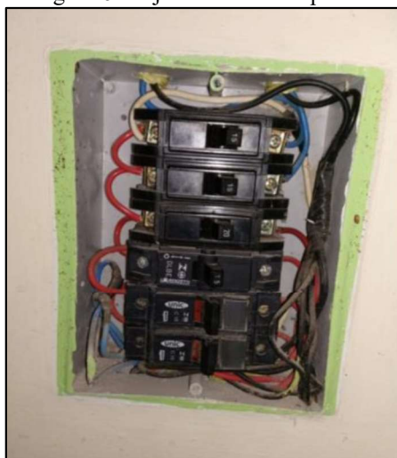
Figura 6-Disjuntores fora do padrão
