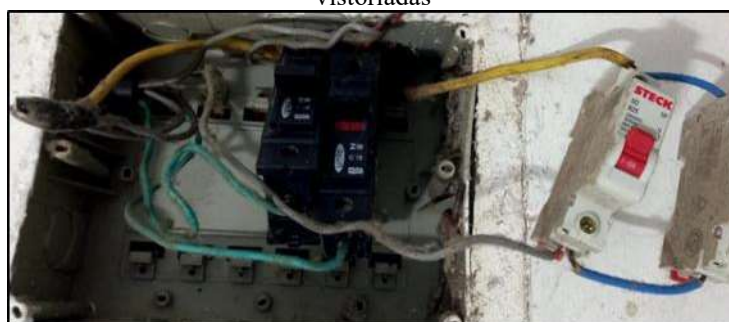
Figura 8-QDG com sinais de corrosão em uma das residências vistoriadas
