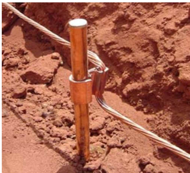
Figura 8 - Haste de aterramento
