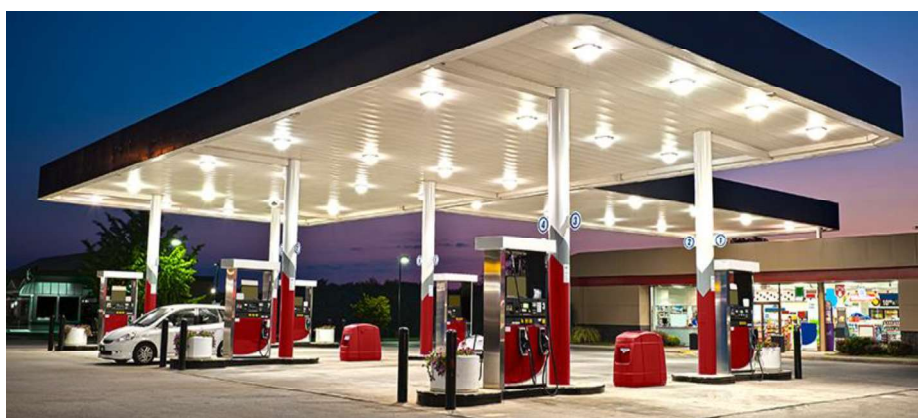
Figura 2 - Cobertura metálica usada como SPDA em posto de combustível
