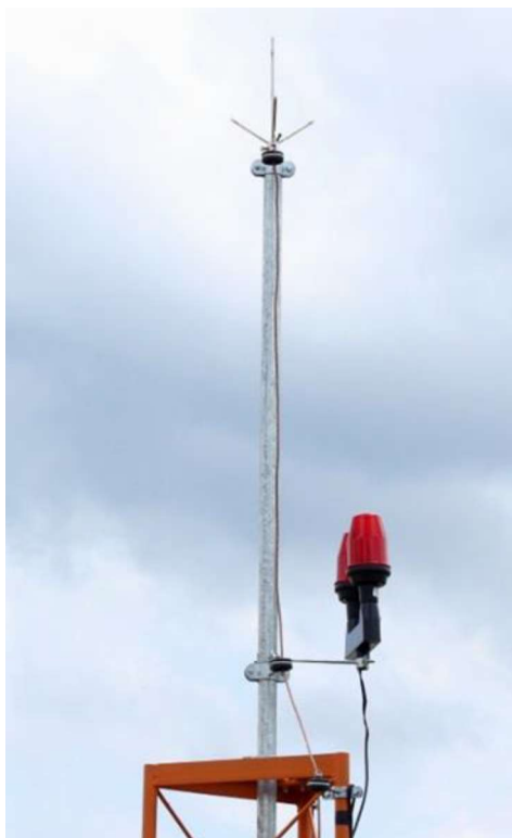
Figura 3 - Captor Franklin no topo de edifício.
