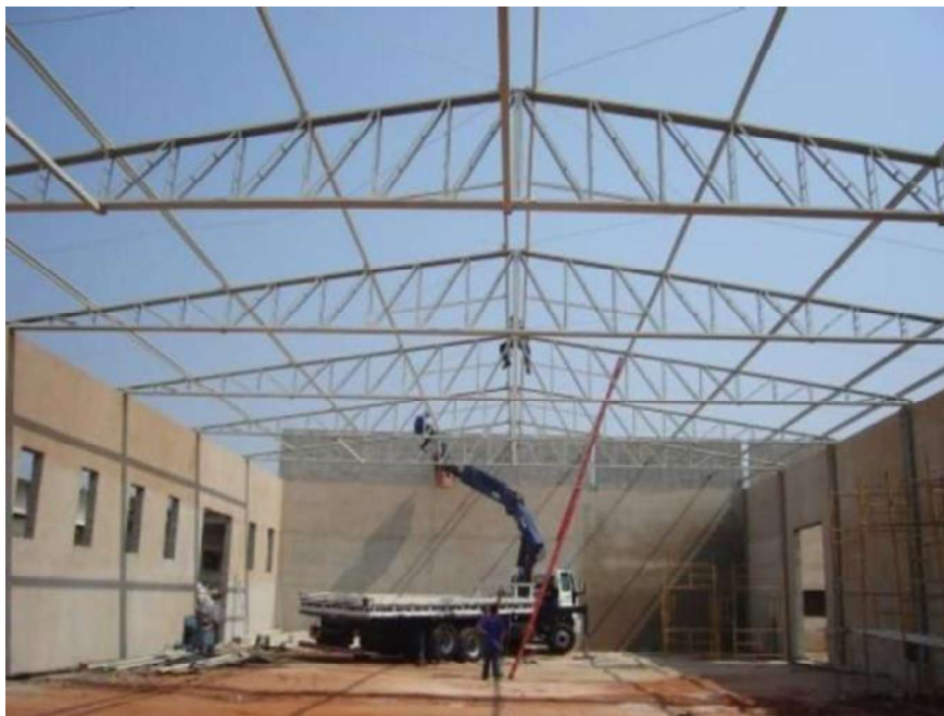
Figura 6 - Armação de aço interligada à estrutura como subsistema de descidas
