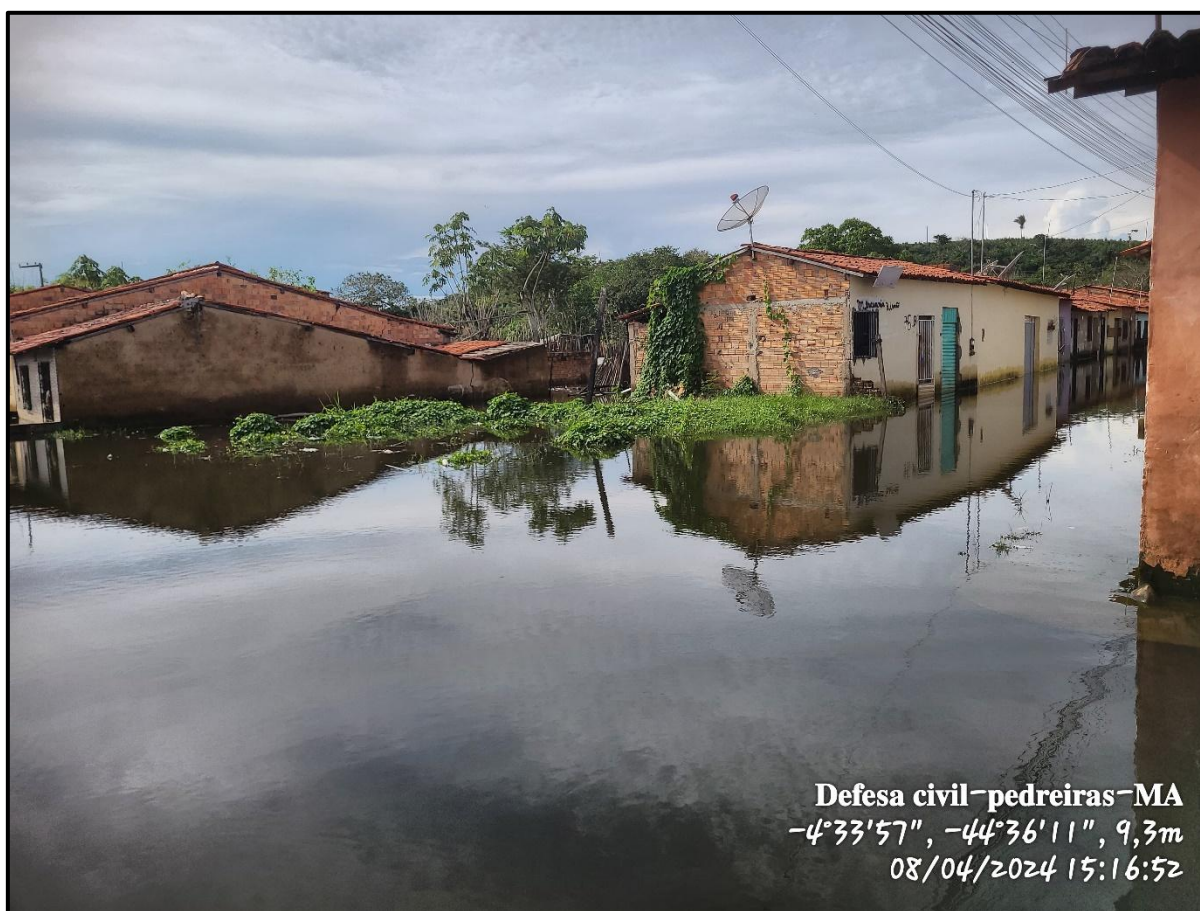
Figura 16 - Ocupação irregular em área de APP com registro de inundação em Pedreiras – MA
