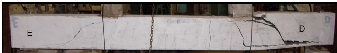
Foto 4.6 – Viga V60-1 fissurada
