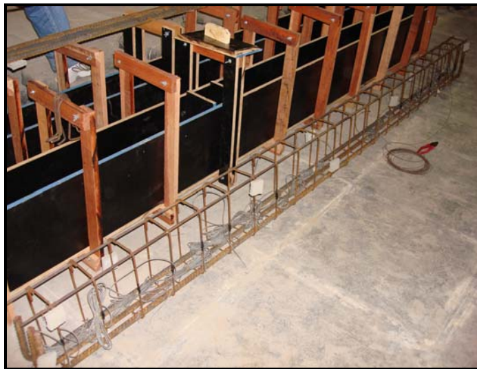
Foto 3.3 - Localização dos extensômetros elétricos nas armaduras das vigas
