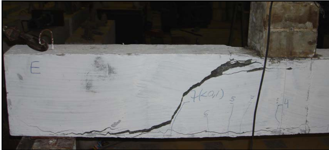
(a) - Fissura única de cisalhamento – V70-1.1
