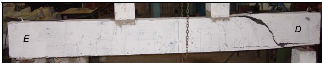
Foto 4.10 – Viga V90- 1 fissurada
