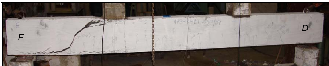
Foto 4.8 – Viga V70-1.1 fissurada
