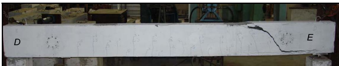
Foto 4.7 – Viga V70- 1 fissurada
