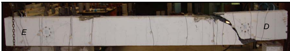
Foto 4.14 – Viga V90- 2 fissurada
