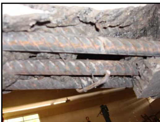
Foto 4.15 – Rompimento de estribo na viga V80-2
