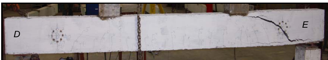
Foto 4.5 - Viga V50- 1 fissurada
