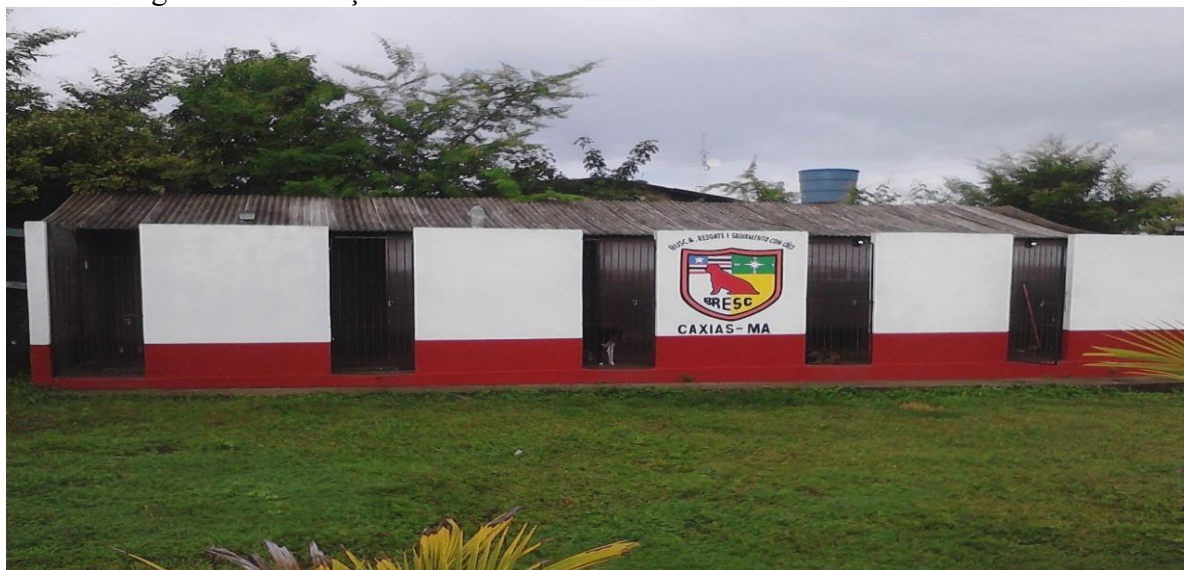
Imagem 2 – Instalação Física do Canil do 5º BBM na cidade de Caxias – MA
