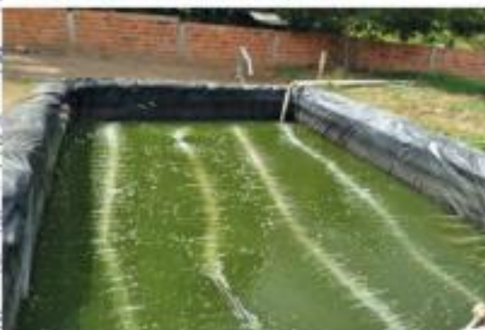
TANQUE DE GEOMEMBRANA
