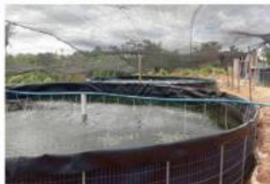
TANQUE DE GEOMEMBRANA
