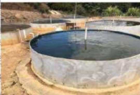
TANQUE DE FIBROCIMENTO
