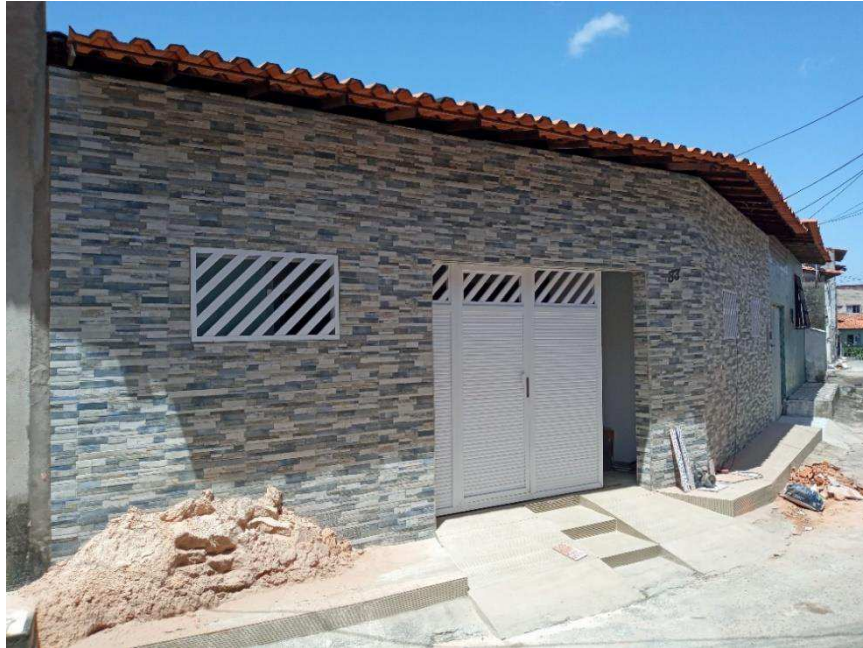
Imagem 17: Fachada da casa 4.
