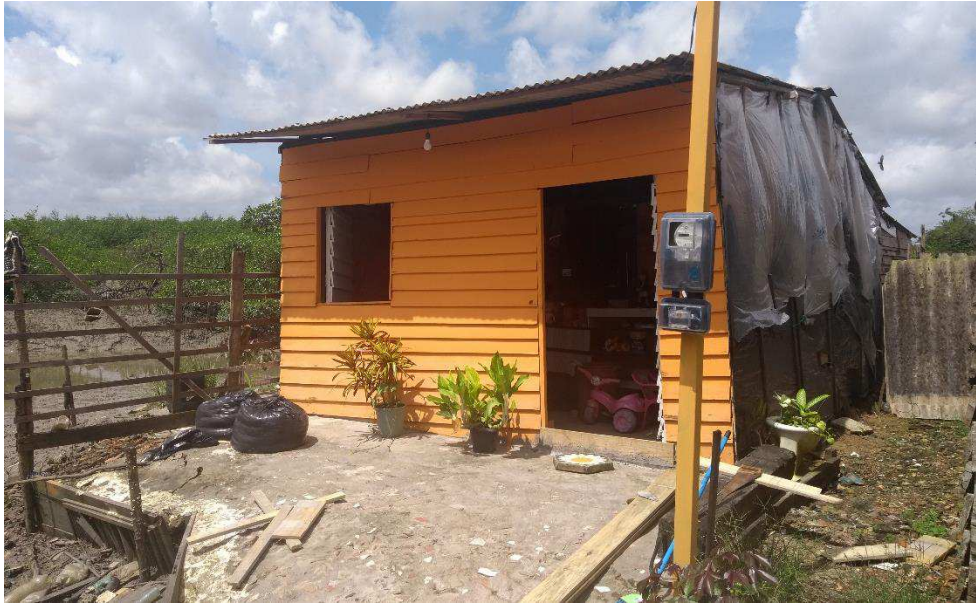
Imagem 22: Fachada da casa 6.
