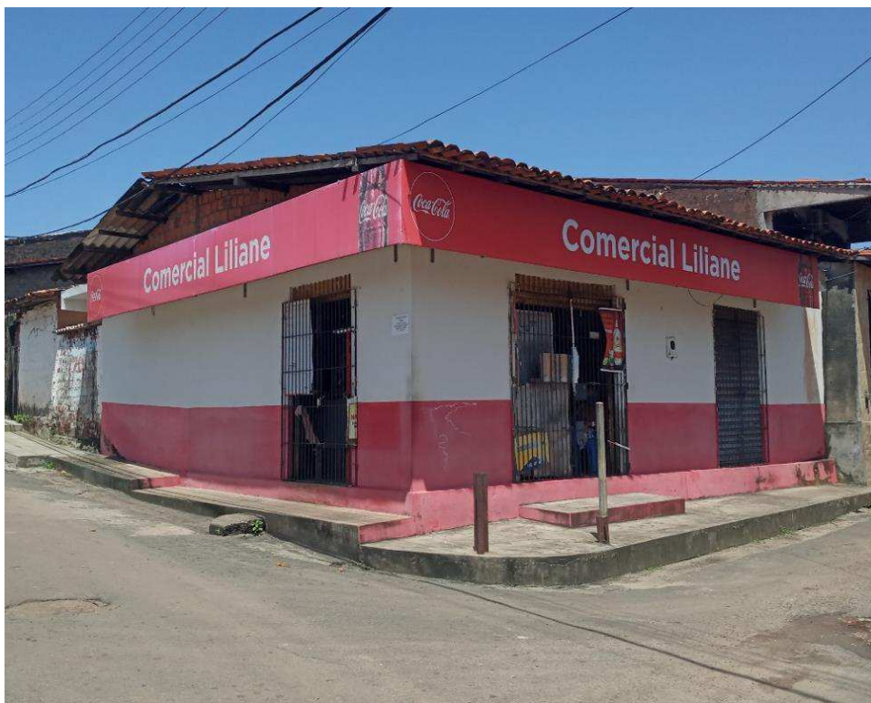
Imagem 14: Fachada da casa 2.
