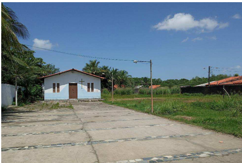
Imagem 11: Igreja de São Raimundo Nonato atualmente.
