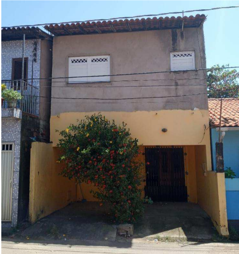
Imagem 15: Fachada da casa 3.
