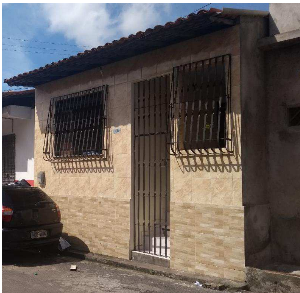
Imagem 19: Fachada da casa 5.
