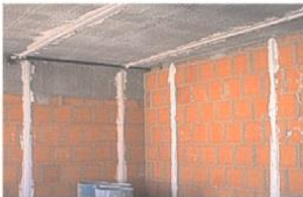
Figura 6 – Mestras para aplicação de revestimento de gesso
