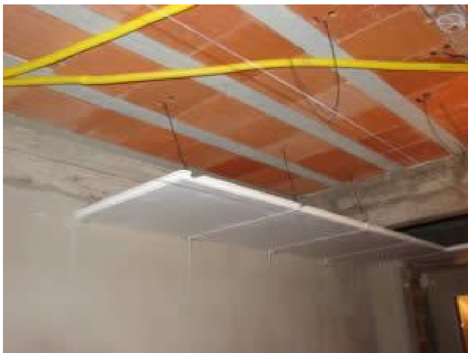
Figura 2 – Fixação de blocos de gesso com arame em laje
