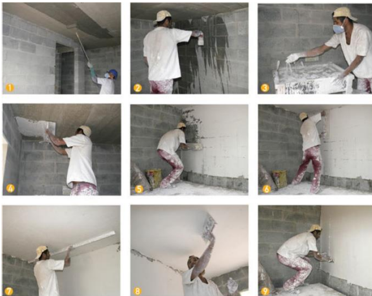
Figura 7 – Etapas de aplicação de gesso no teto e paredes.
