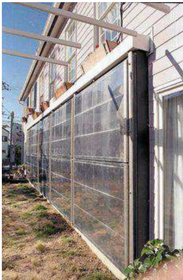
Figura 6 – Construção de uma Parede Trombe na faixa da casa
