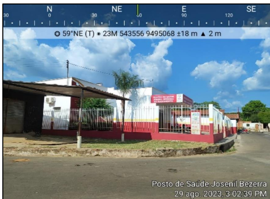
IMAGEM 16 – Posto de Saúde Bairro Baixada, Trizidela do Vale
