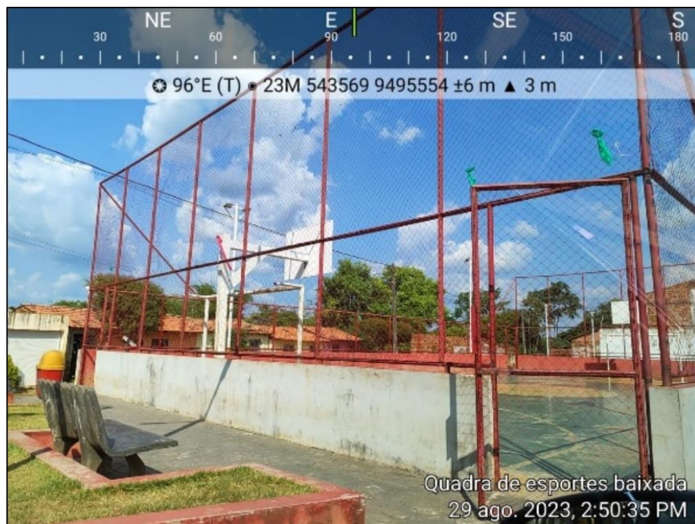
IMAGEM 18 – Quadra de Esportes Bairro Baixada, Trizidela do Vale – MA
