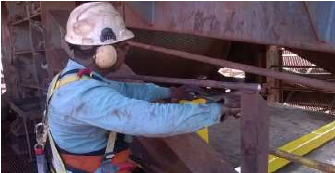
Figura 26 - Funcionário realiza o amordaçamento de forma segura sem exposição.
