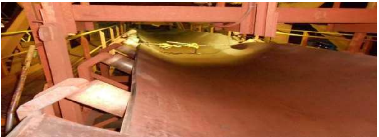
Figura 23 - Correia amordaçada com talha antes da atividade.
