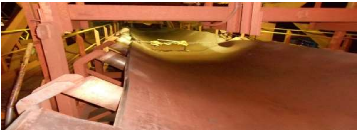
Figura 23 - Correia amordaçada com talha antes da atividade.
