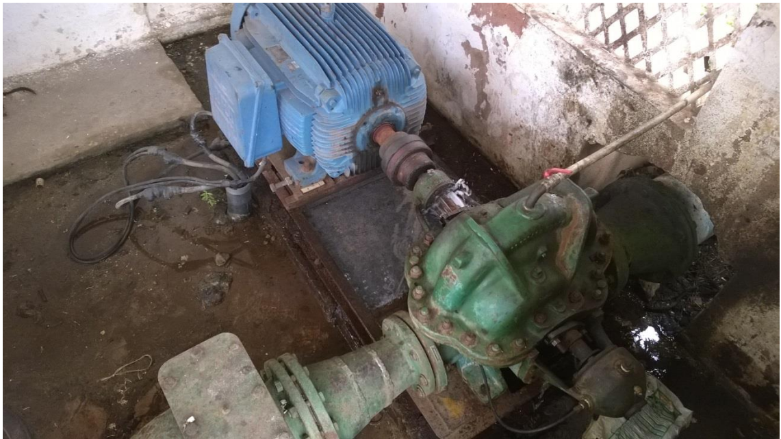
Figura 43. Colocação do Acoplamento
