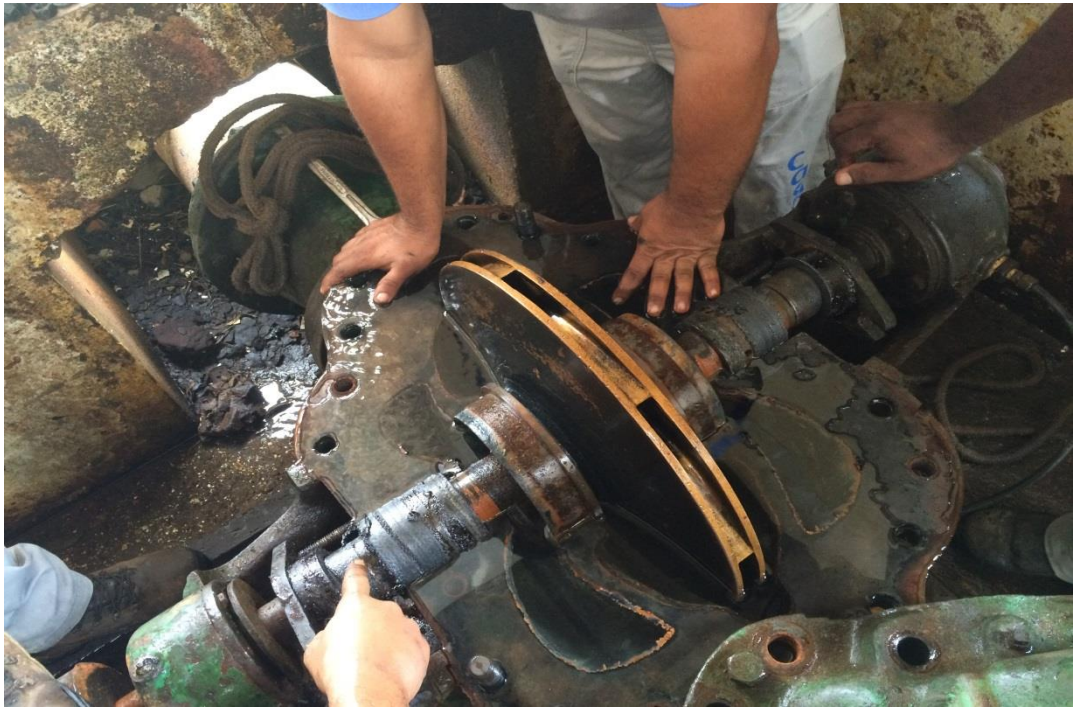
Figura 41. Colocação da caixa de gaxetas
