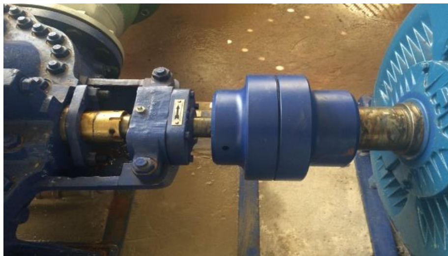
Figura 57. Substituição do Acoplamento
