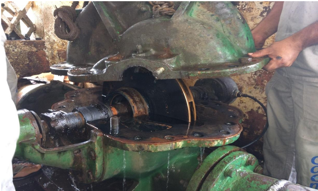
Figura 42. Colocação da Carcaça.
