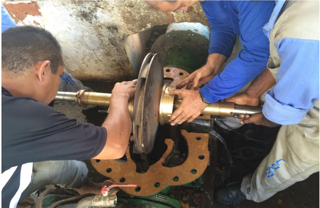
Figura 38. Colocação do conjunto girante na voluta.
