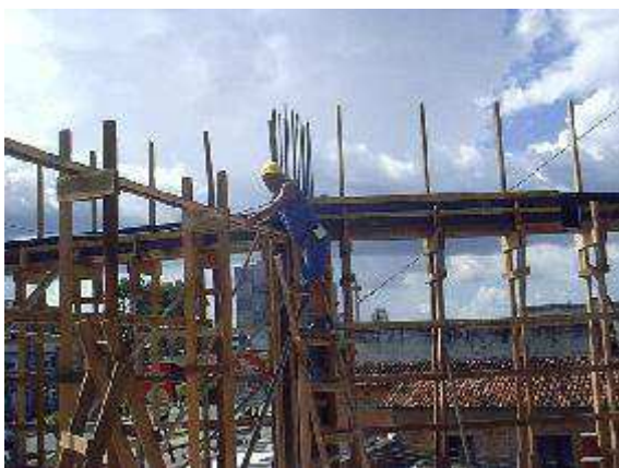
Figura 7 – lançamento dos fundos de viga, a partir da cabeça dos pilares.
