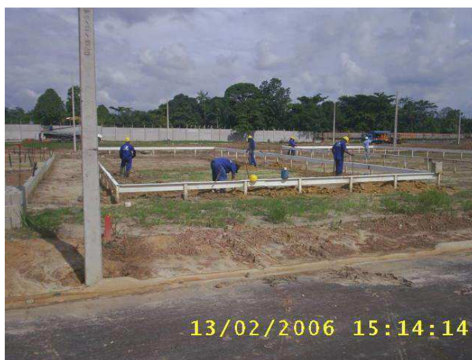
Figura 01 – Execução do gabarito.
