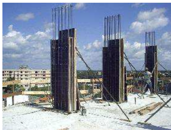
Figura 4 - Armaduras posicionadas, com as faces da forma do pilar devidamente travadas.
