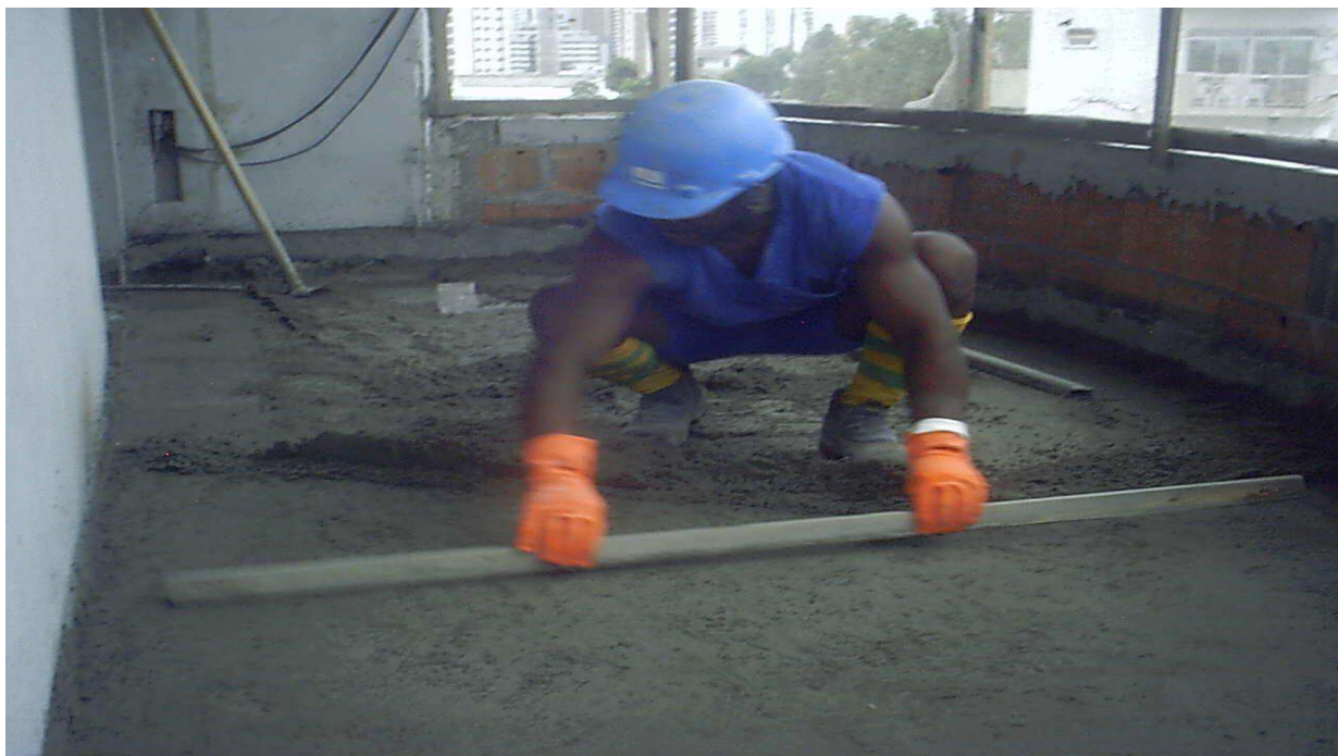
Figura 14: Sarrafeamento de argamassa entre mestras
