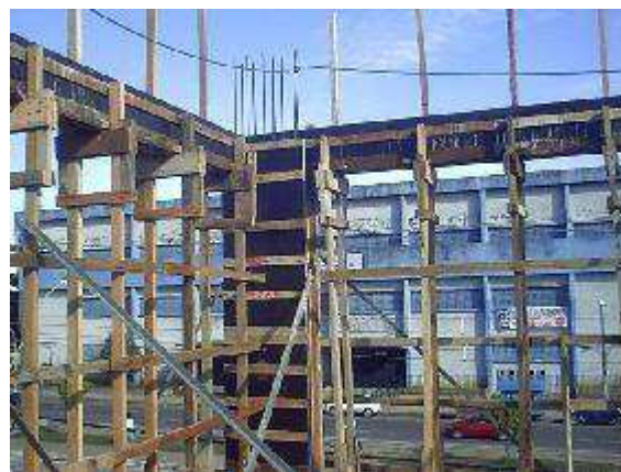
Figura 8 - Posicionamento dos painéis laterais das vigas sem o seu encunhamento.
