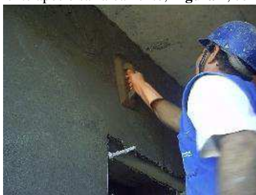
Figura 4 - Desempeno da superfície com madeira para o acabamento final.
