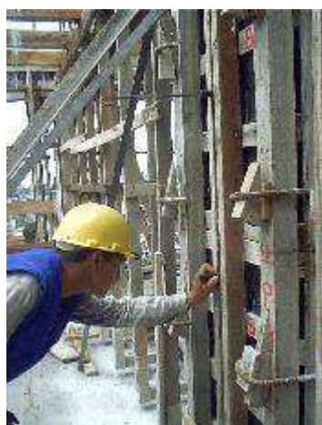
Figura 5 - Posicionamento de mangueira e tirante
