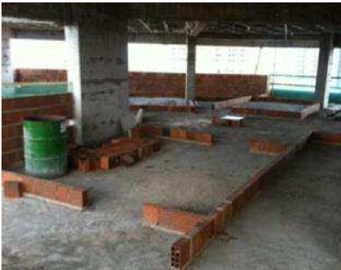
Figura 20: Serviço de assentamento de alvenaria..
