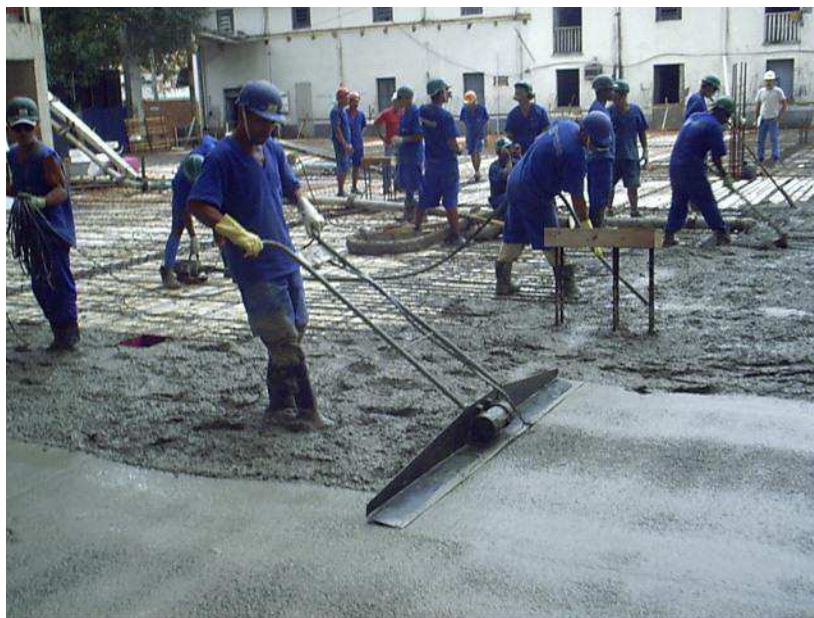
Figura 2 - Sarrafeamento de laje com régua vibratória.
