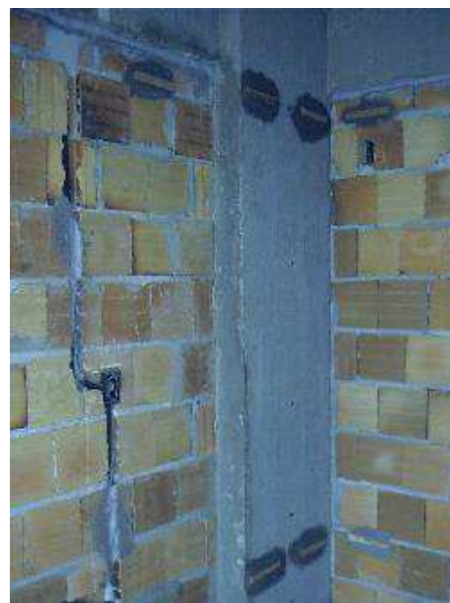
Figura 1 - Assentamento das taliscas
