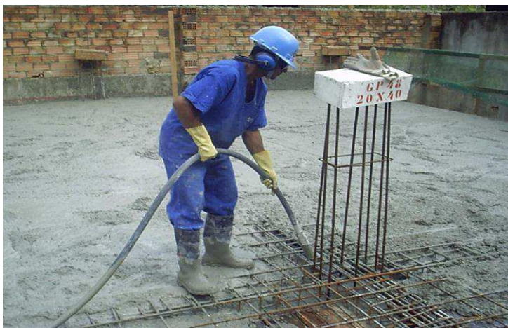
Figura 3 - Adensamento do concreto de pilar com auxílio de um vibrador de agulha de imersão
