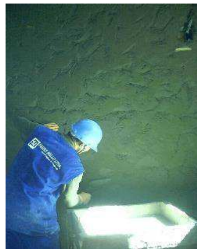
Figura 2 – Aplicação da argamassa
