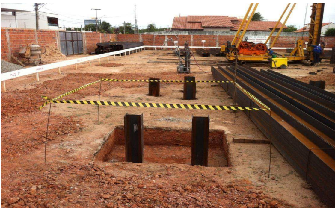
Figura 7 Perfis metálicos utilizados na fundação
