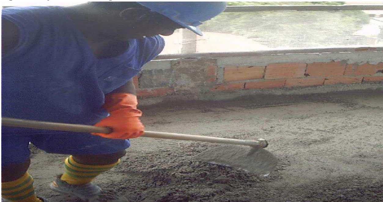
Figura 12 Espalhamento de argamassa
