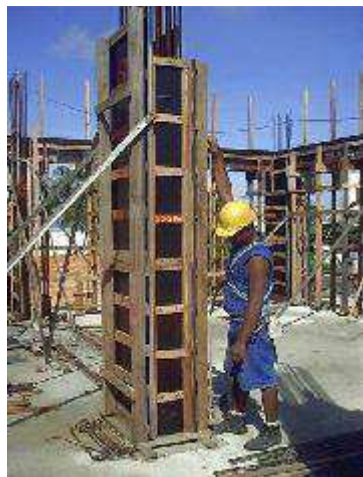
Figura 3 - Montagem de forma de pilar com conferência de prumo.
