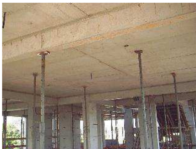
Figura 10 – Lajes e vigas reescoradas
