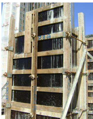
Figura 6 - Travamento de forma de pilar por meio de gravatas, tensores e castanhas
