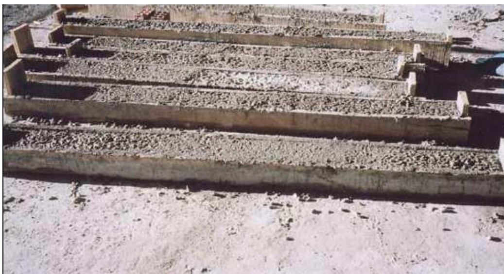
Figura 17: Fabricação de vergas no canteiro de obras
