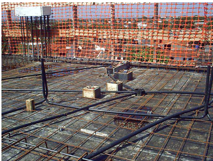
Figura 1 - Posicionamento dos gabaritos para locação das instalações
