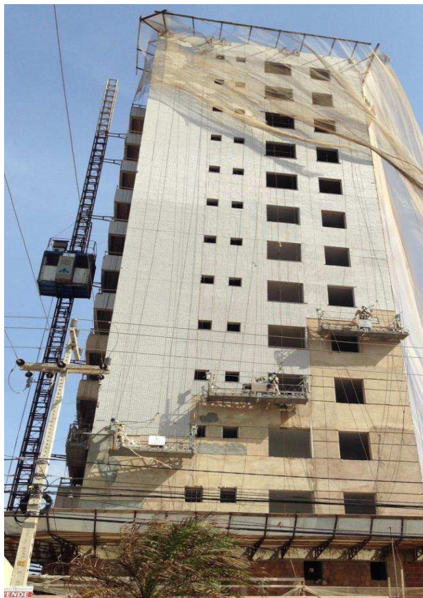
Figura 9: Vista lateral do Edifício Monte Carlo em fase de revestimento externo.
