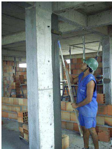
FIGURA 02 - Aplicação de chapisco rolado com rolo para textura.
