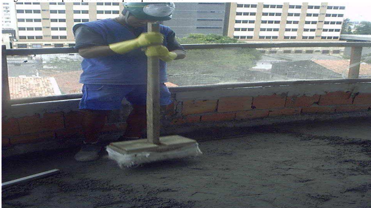
Figura 13: Compactação com soquete padronizado
