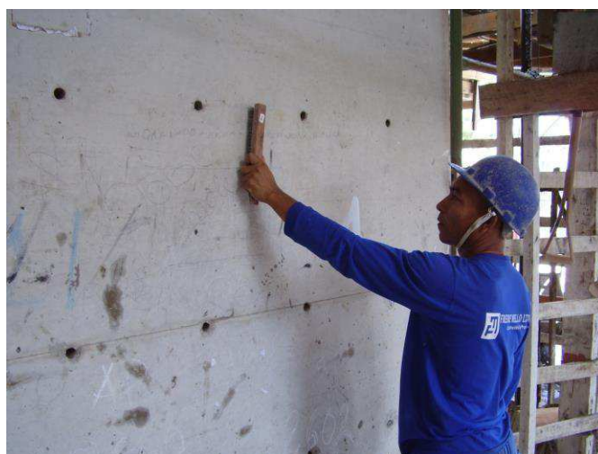
Figura 01 – Limpeza da superfície.
