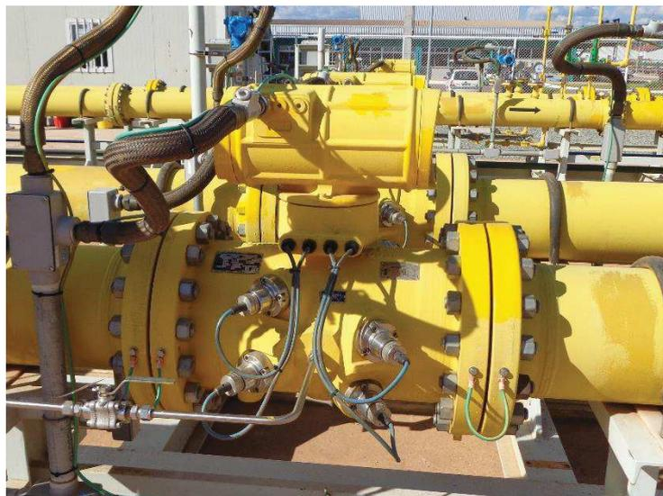
Figura 5 – Medidor de vazão utilizado
