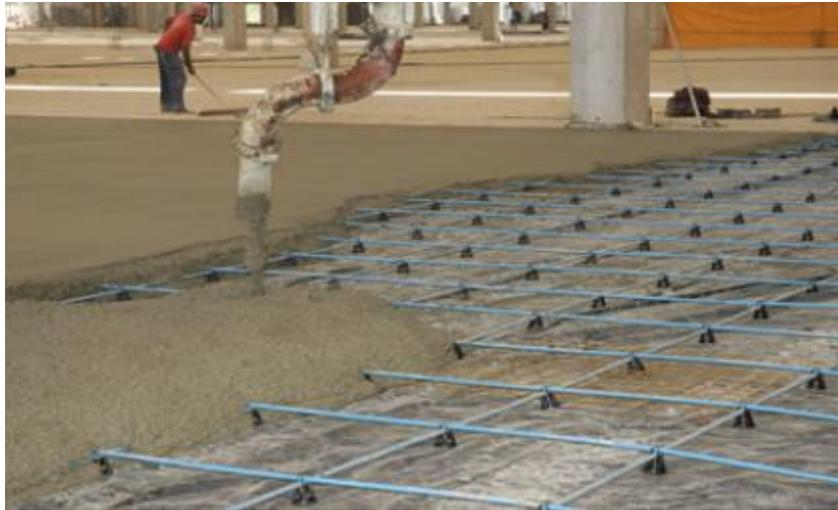
Já com o concreto despejado sobre o pano de concretagem se tem início seu processo de adensamento, obtido por meio do uso de equipamentos vibratórios (régua vibratória manual ou vibrador por imersão), para garantir que o concreto preencha todo o volume do pano de concretagem.
