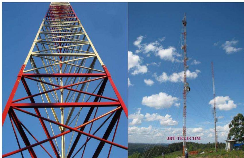
Figura 1 – Tipos de Torres em Telecomunicações: Autoportante (esquerda) e Estaiada (direita)
