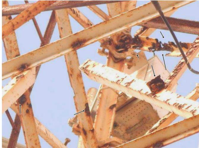
Figura 2 – Corrosão Generalizada em uma torre metálica
