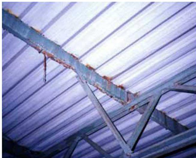
Figura 9 – Corrosão Galvânica
