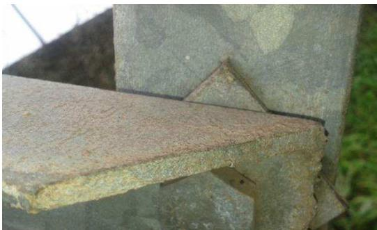
Figura 36 – Frestas 2 - contato superfície com superfície
