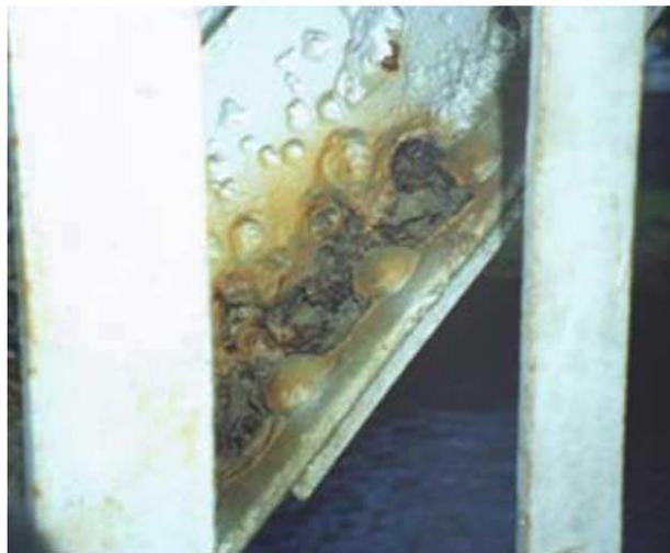
Figura 10 – Corrosão Puntiforme
