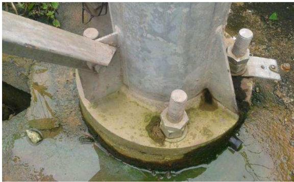
Figura 34 – Acúmulo de água em uma das bases
