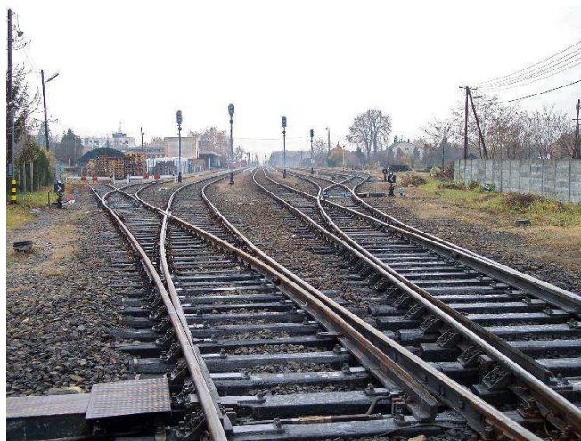
Figura 3 – Aparelho de Mudança de Via
