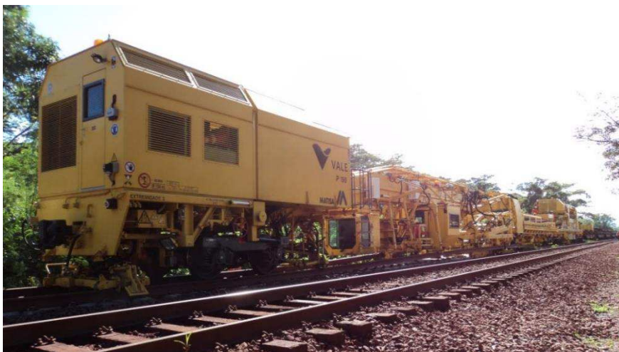
Figura 7 – Renovadora de Linha
