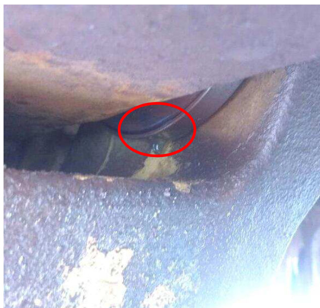
Figura 18 – Vazamento no Braço da Banca de Socaria
