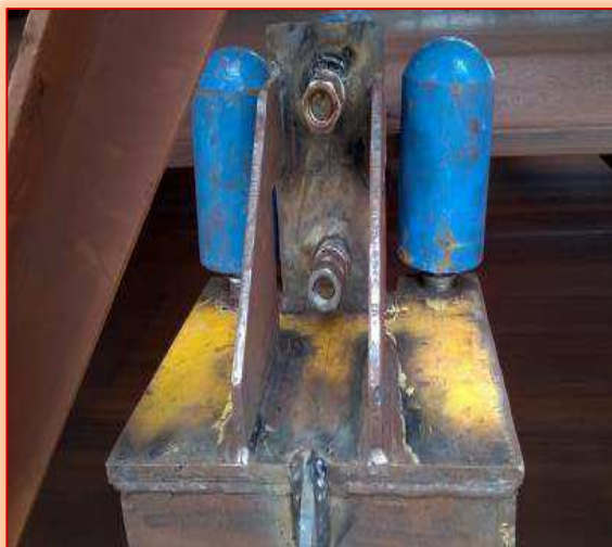
Figura 19 – Instalação do dispositivo no CN3
