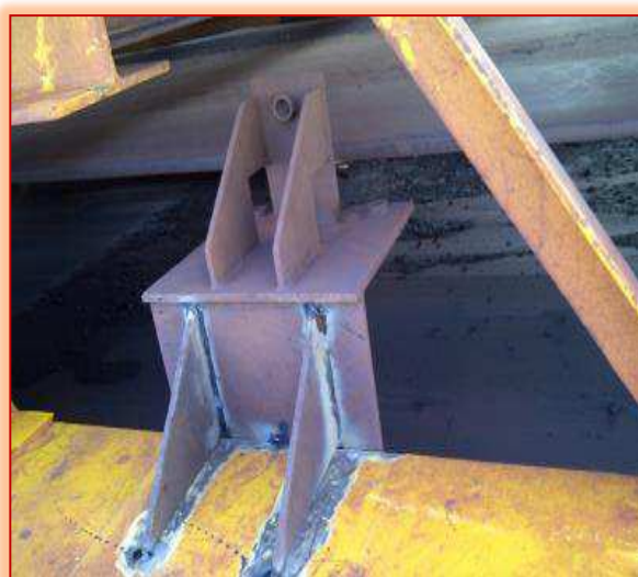
Figura 18 – Montagem do dispositivo na área
