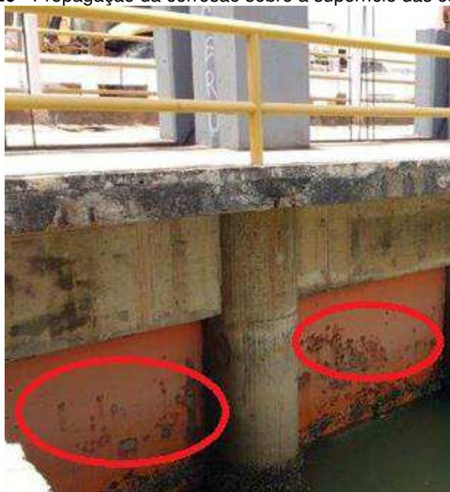
Verificou-se também através dos ensaios visuais que, as comportas metálicas estão diretamente em contato com a água do mar como mostra em destaque a (Figura 27). Segundo GENTIL (2012), nesse meio ocorre à redução do oxigênio por está em contato direto com as estruturas metálicas, contribuindo para o aparecimento da corrosão.
