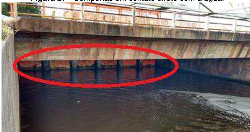
Outro ponto identificado com a realização das inspeções visuais foi a instalação bastante acentuada de cracas nas partes inferiores das comportas (Figura 28). Segundo GENTIL (2012), esses organismos podem penetrar na película da tinta e, com o seu crescimento, as extremidades afiadas das conchas cortam a película de tinta que dão a proteção às comportas, facilitando para a ocorrência do processo corrosivo.
