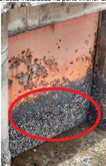
Ainda de acordo com a realização das inspeções visuais foi verificado a deterioração de corrimãos (Figura 29) que fazem parte da estrutura da barragem do Bacanga. Que de acordo com (Reis et.al, 2007) é características do fenômeno da
