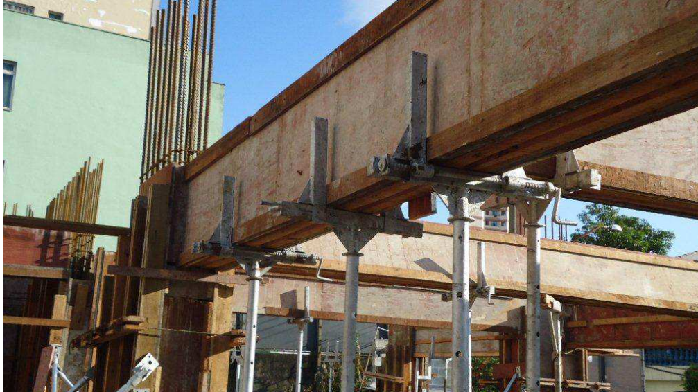
Figura 31 – Imagem de escoramento de viga com escora utilizando garfo interno
