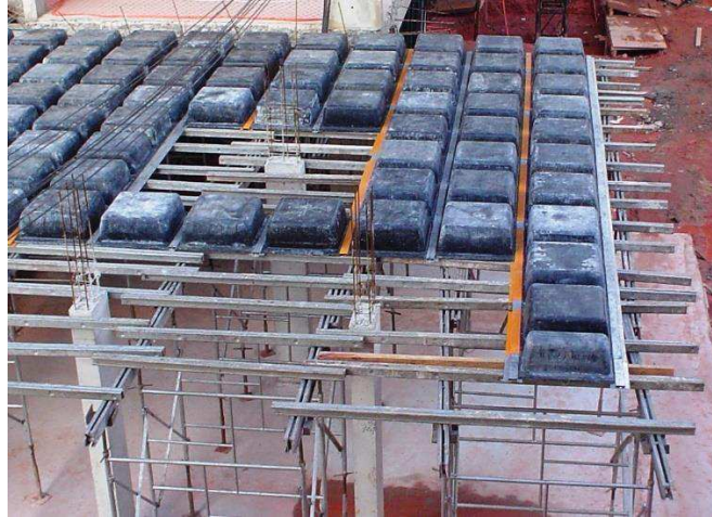
Figura 28 - Foto mostrando as guias de cubeta(cor laranja)
