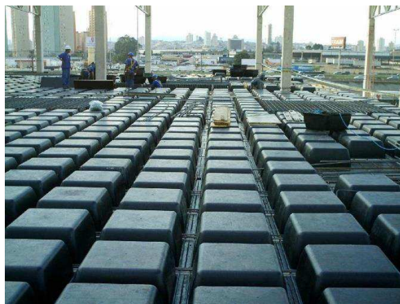
Figura 5 - Laje nervurada
