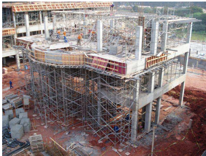
Figura 37 – Imagem de escoramento em balanço
