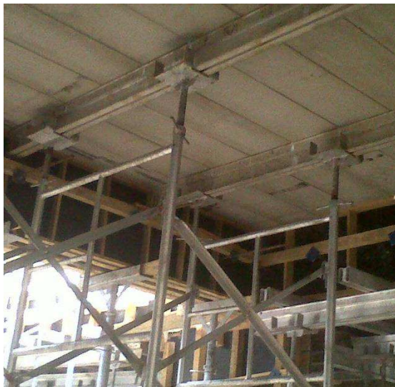
Figura 26 – Imagens de escoramentos com lajes mistas
