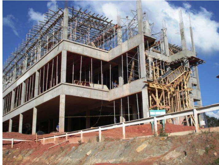
Figura 39 – Escoramento de escada feito de madeira
