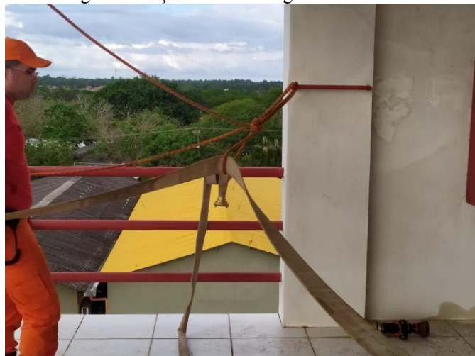
Figura 59 - Içamento de mangueira no 4º andar
