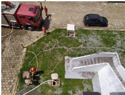
Figura 57 - Pressurização do sistema de hidrante de recalque
