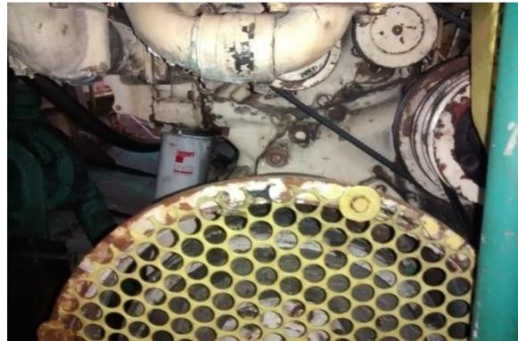
Figura 15 – Parafusos e carcaça de proteção da correia sofrendo corrosão.
