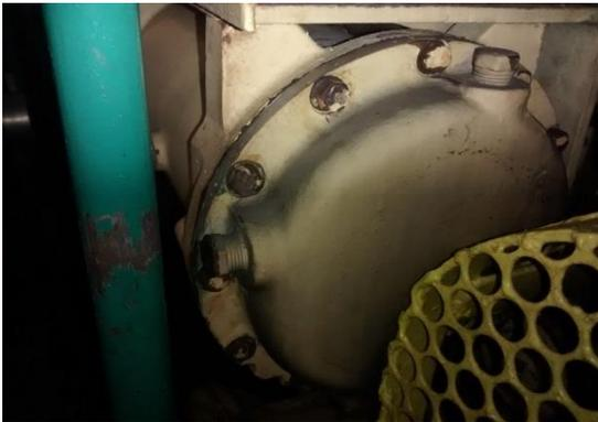
Figura 14 – Parafusos sofrendo corrosão.
