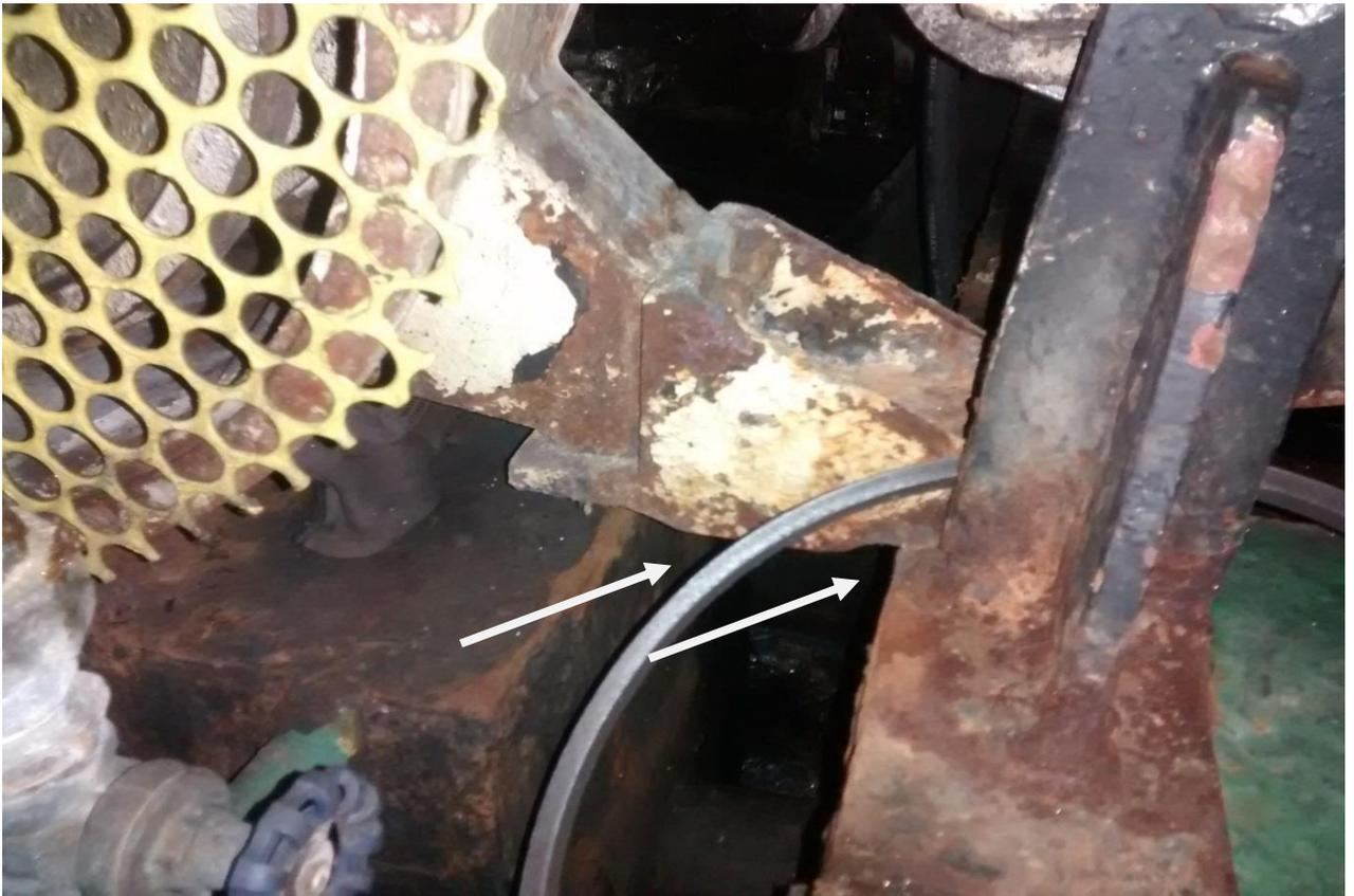
Figura 18 – Foto panorâmica do pé da base do motor mostrando corrosão no mancal.
