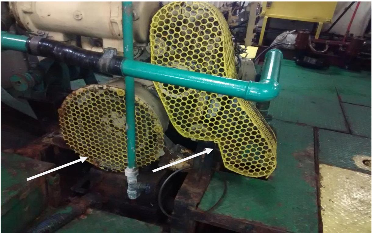
Figura 17 – Foto da carcaça de proteção da correia mostrando corrosão.
