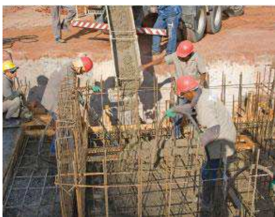
Figura 48: Concretagem da sapata corrida
