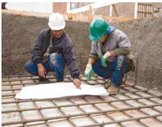
Figura 44: Armadura da sapata corrida
