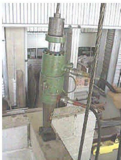
Figura 60: Aplicação de protensão em cordoalha com a utilização de macaco hidráulico
