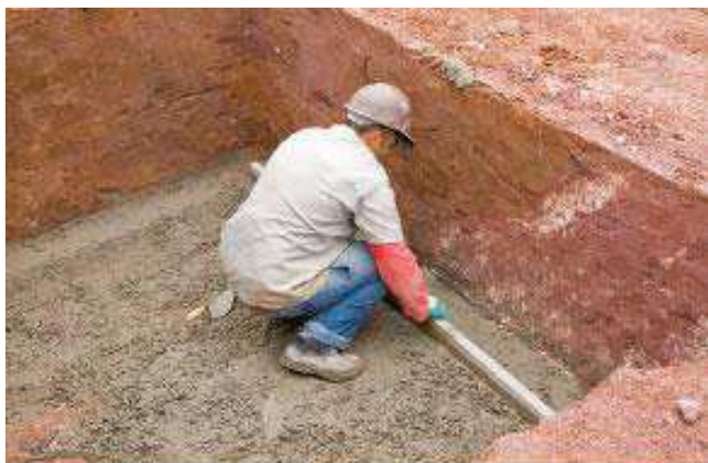
Figura 41: Lastro de concreto magro
