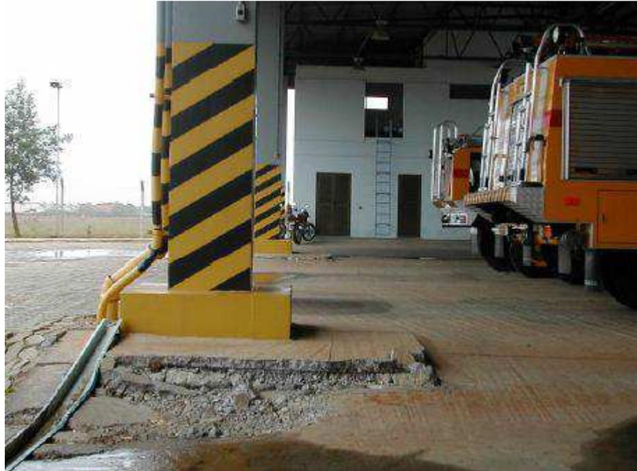
**Figura 33** – Efeitos do assentamento da estrutura provocado pela compactação do aterro sobre as camadas mais frágeis (Schnaid, 2006).
