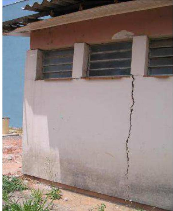
**Figura 10** – A) e B), exemplos dos danos provocados devido a variação volumétrica do solo (Apontamentos da disciplina de Fundações [1]).
