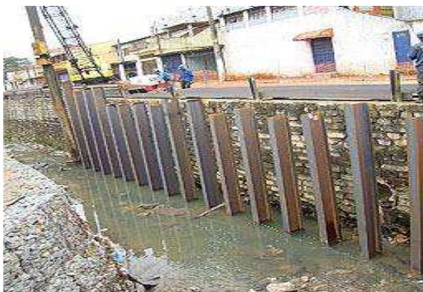
**Figura 47** – Exemplo de aplicação de estaca metálica parcialmente cravada, em água doce muito poluída. Adaptado do site [www.scribb.com](http://www.scribb.com)
