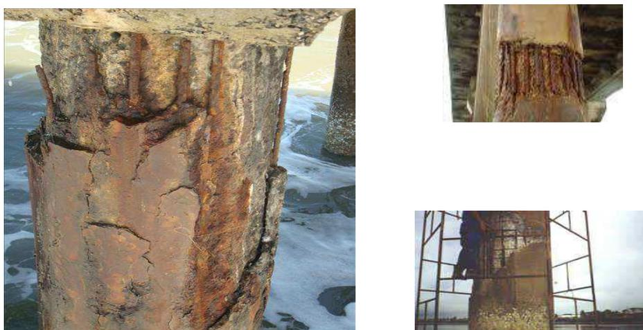
**Figura 45** – Exemplos de estaca de concreto com degradação relacionada a ataque de sulfato
