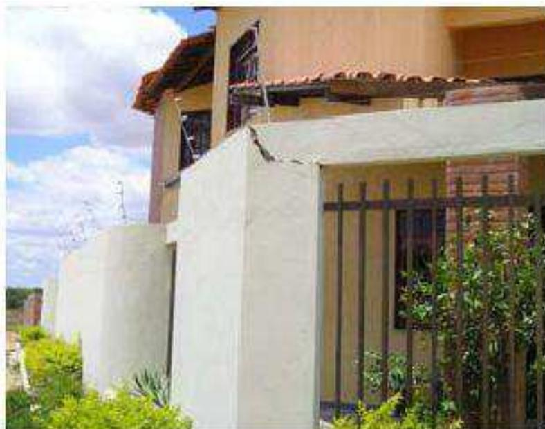
**Figura 11** - Ruptura de um pórtico causada por expansão de solos – Município de Poço Verde – SE (Cavalcante et al., 2006).
