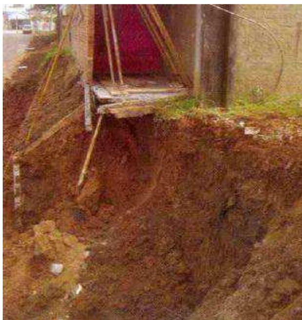
**Figura 40** – Descalçamento das fundações da estrutura devido a escavações próximas (Schnaid, 2006).
