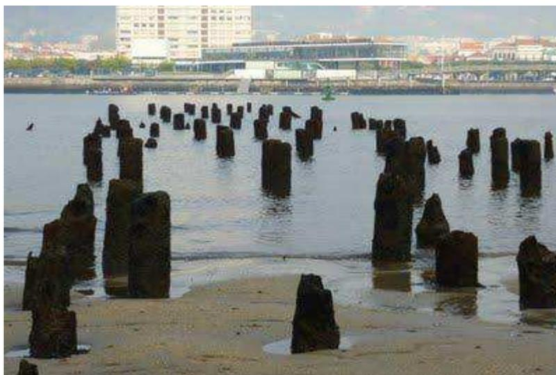
**Figura 48** – Estacas de uma antiga ponte de madeira, com danos causados pela degradação. Adaptado do site [www.scribb.com](http://www.scribb.com)
