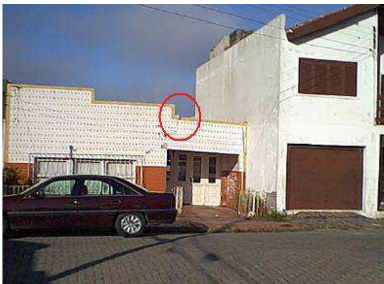
**Figura 39** – Problemas causados pela construção de novas estruturas sem junta de separação (Schnaid, 2006).
