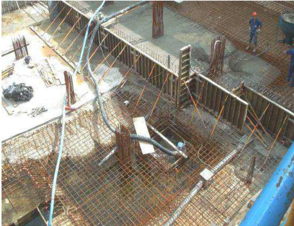
**Figura 37** – Redução do nível freático com ajuda de bombas durante a betonagem (Fritz, 2009).
