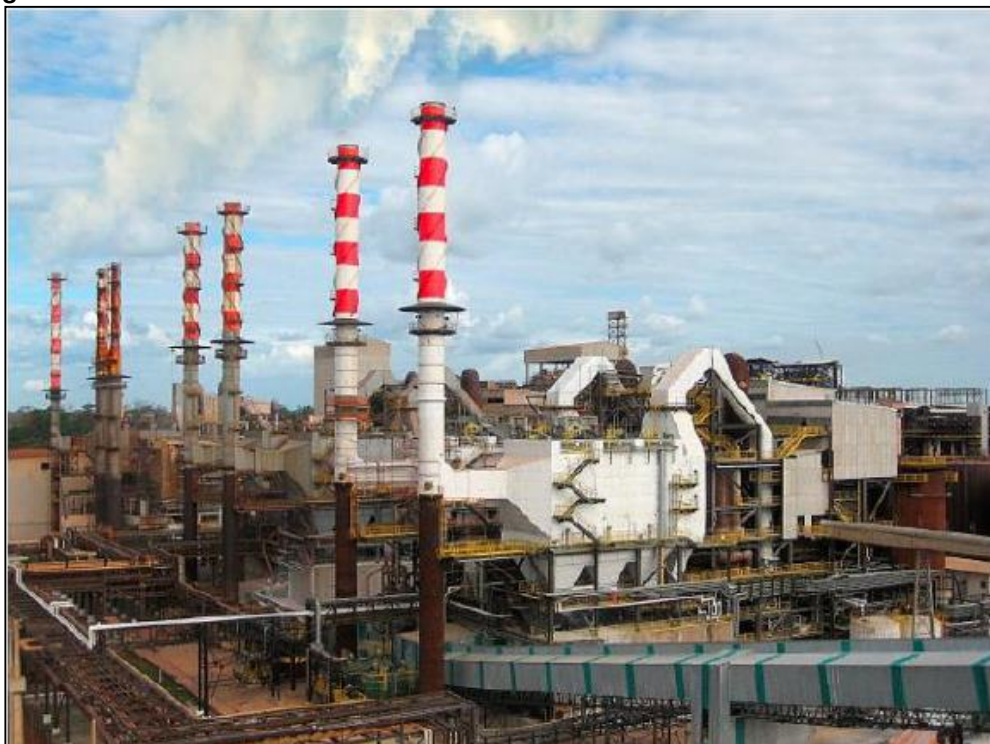
Figura 10 - Calcinadores de Leito Fluidizado Circulante instalados em indústria no Pará.
