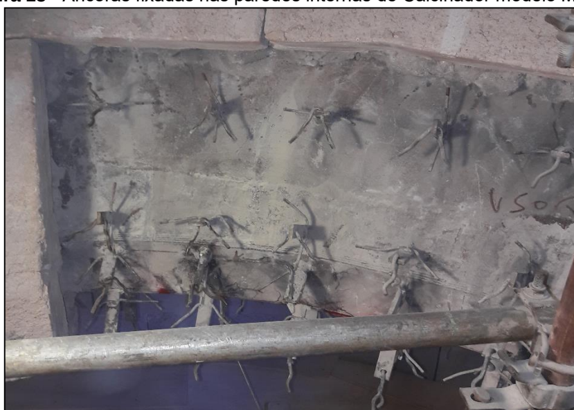
Figura 13 - Âncoras fixadas nas paredes internas de Calcinador modelo Mark 7
