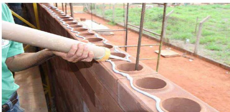
Figura 32 – Aplicação de cola de argamassa durante o assentamento do Tijolo Modular
