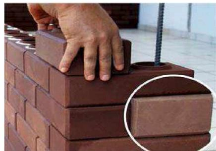
Figura 11 – Alvenaria com meio Tijolo Modular Padrão
