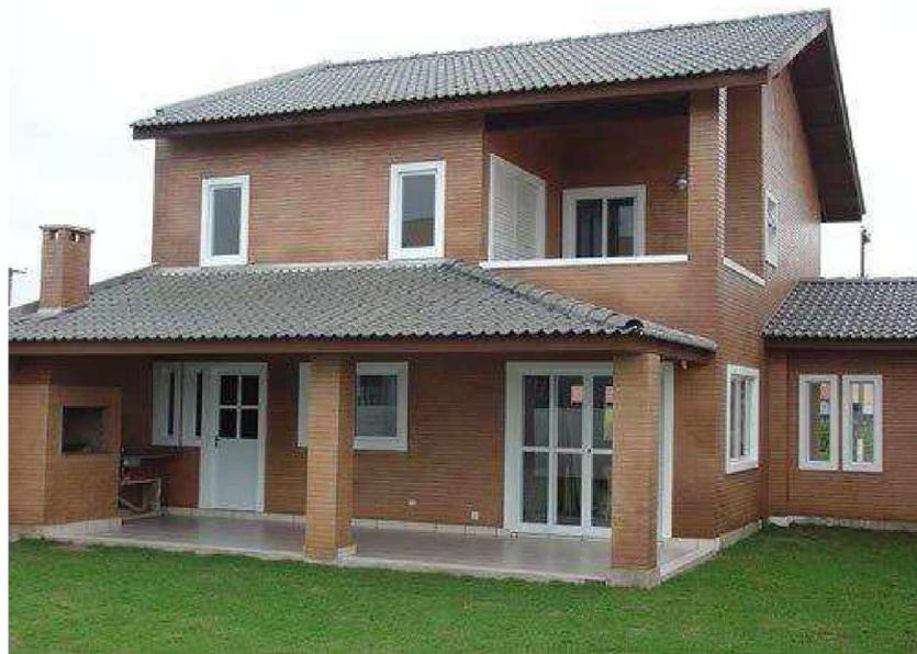
Figura 40 – Casa com dois pavimentos de alvenaria ecológica
