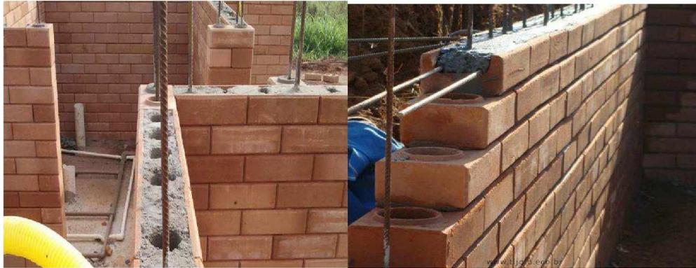
Figura 35 – Fiada de canaleta modular grauteada com vergalhões devidamente dispostos
