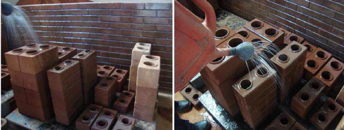
Figura 26 – Tijolos sendo umedecidos após seis horas de prensados
