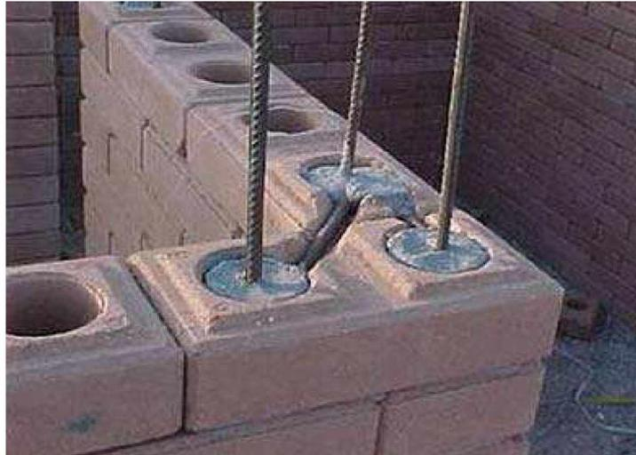
Figura 29 – Canto de alvenaria grauteado
