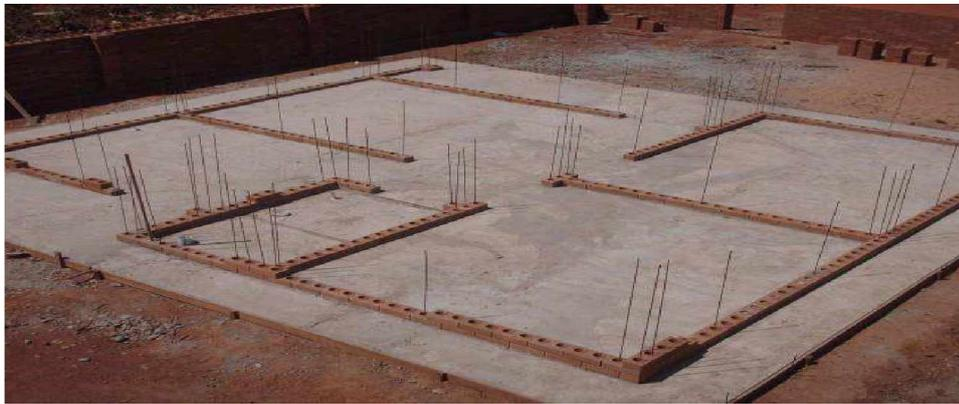
Figura 33 – Ferros longitudinalmente fixados após a primeira fiada da alvenaria modular
