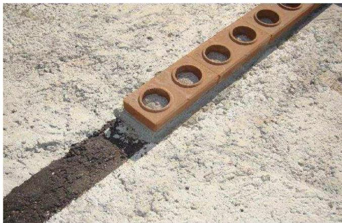
Figura 31 – Primeira fiada no assentamento do Tijolo
