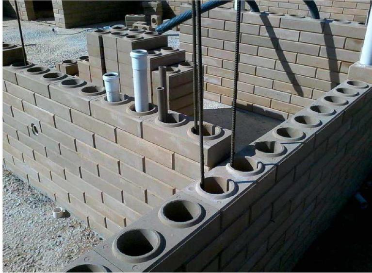
Figura 28 – Elementos do sistema hidráulico instalados entre os furos do Tijolo Modular
