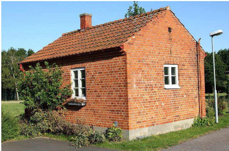
Figura 38 – Casa pequena com alvenaria de tijolo ecológico
