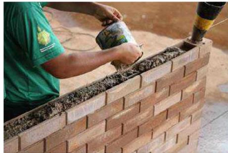
Figura 13 – Cimentação de reforço em alvenaria de Tijolo Canaleta Modular Padrão
