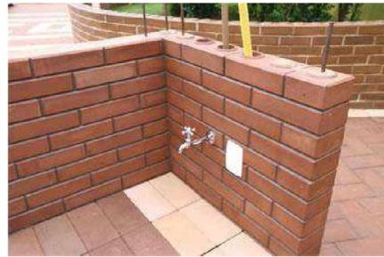
Figura 9 – Alvenaria com Tijolo Modular Padrão
