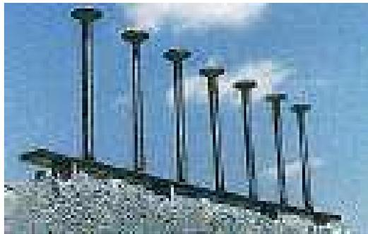
Figura 35 – Detalhe dos conectores
