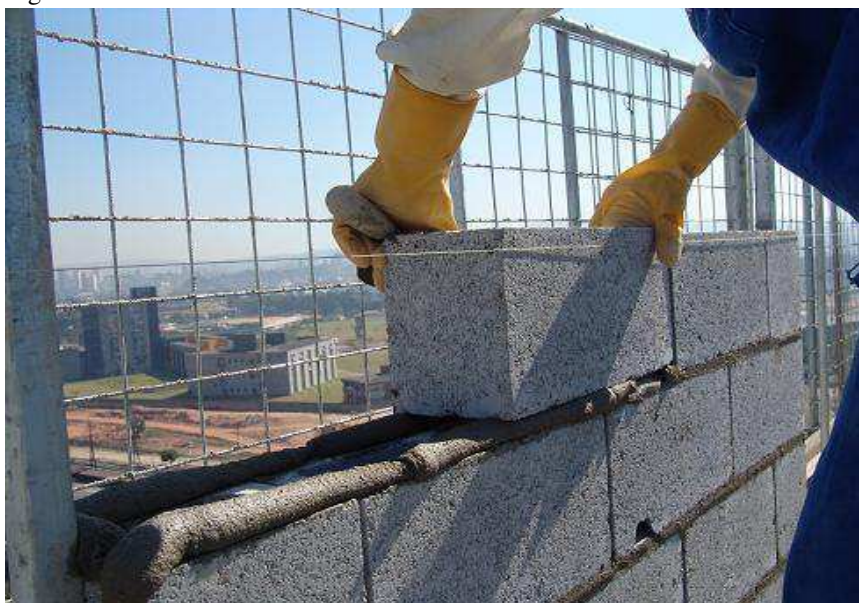
Figura 1 – Obra em alvenaria estrutural.
