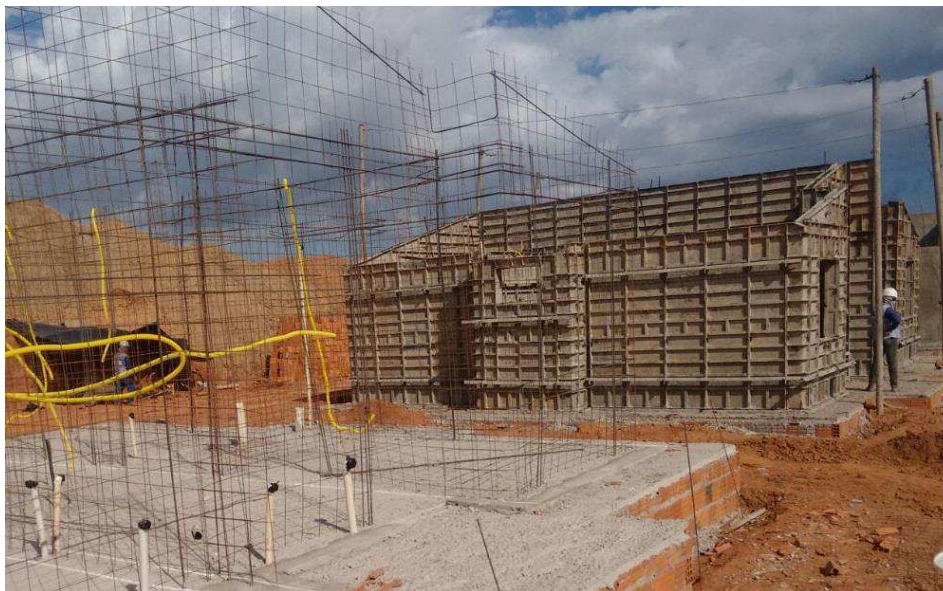
Figura 3 – Armação, instalações e fôrma montada ao fundo.
