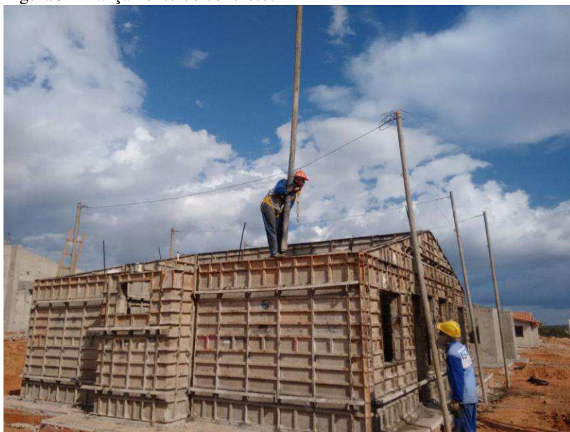
Figura 9 – Lançamento do concreto.
