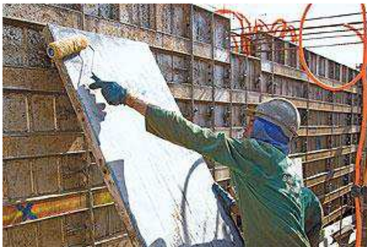
Figura 11 – Aplicação do desmoldante nos painéis de fôrmas.
