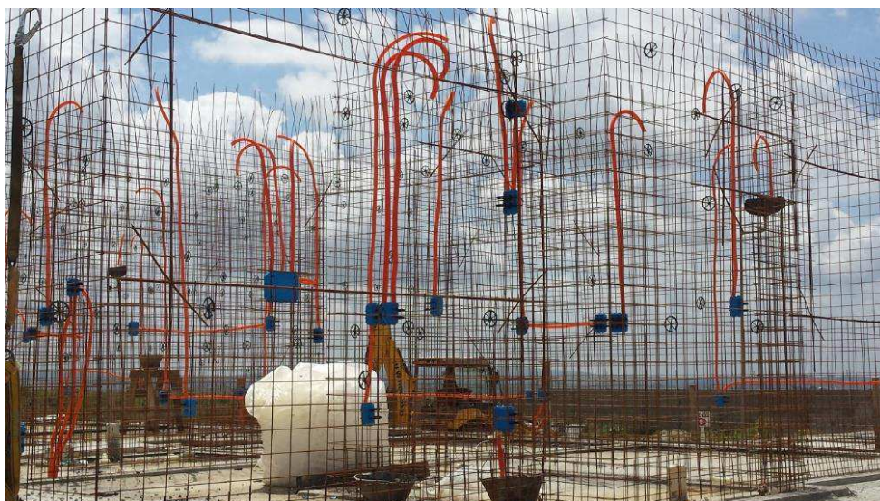
Figura 7 – Armação, eletrodutos e espaçadores.
