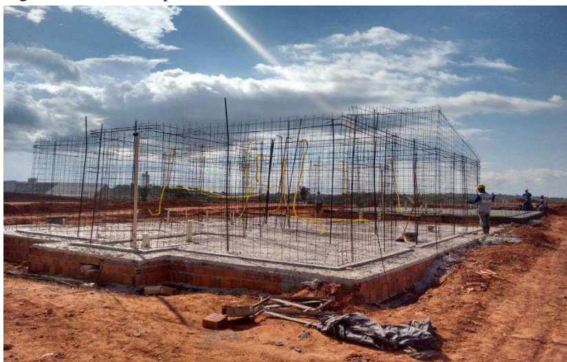
Figura 6 – Armadura paredes de concreto.
