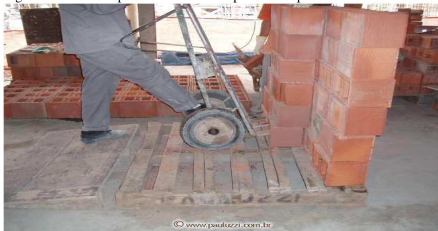
Figura 14 – Uso das paleteiras e carriolas para o transporte de blocos cerâmicos.
