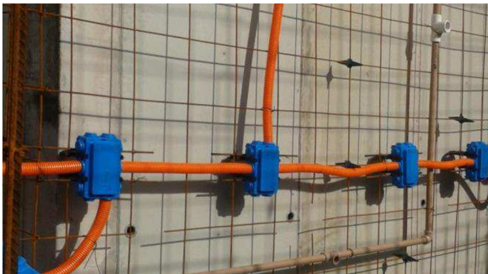
Figura 8 – Instalações elétricas e hidráulicas posicionadas e fixadas.
