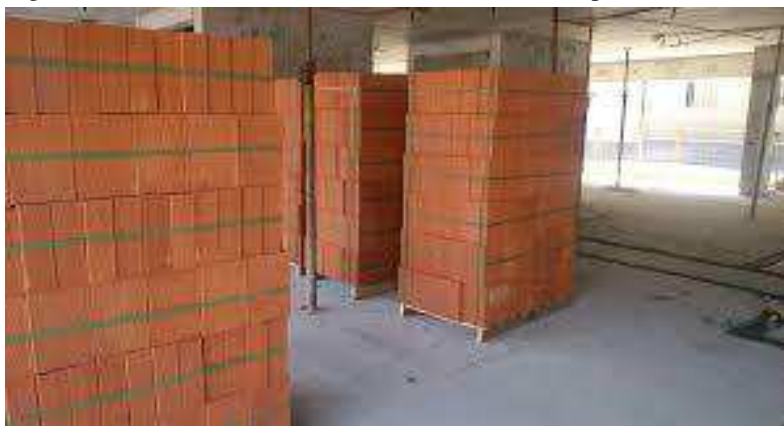
Figura 12 – Armazenamento dos blocos cerâmicos em paletes.
