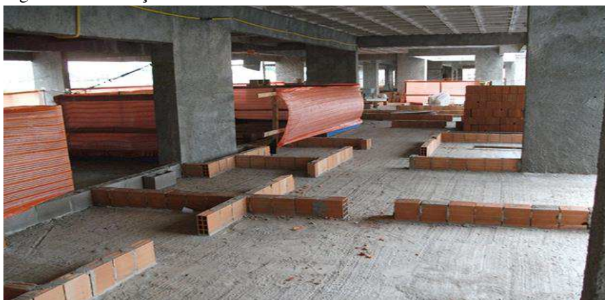
Figura 15 – Marcação de alvenaria com blocos cerâmicos.
