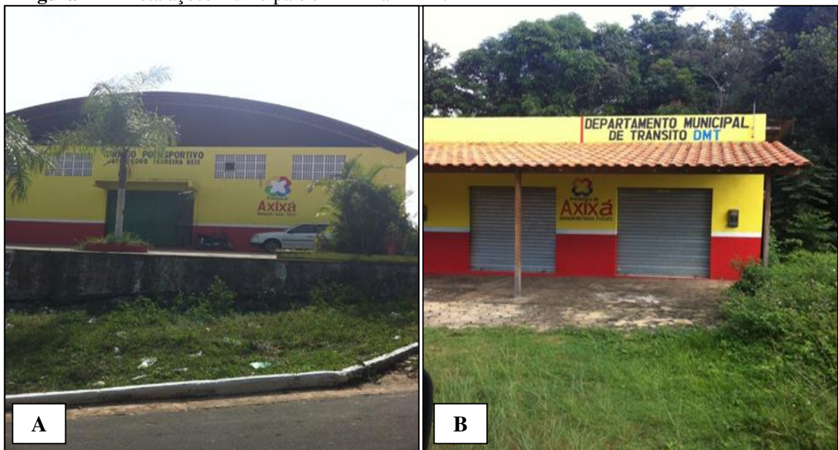
Figura 11 – Instalações municipais em Axixá – MA.
