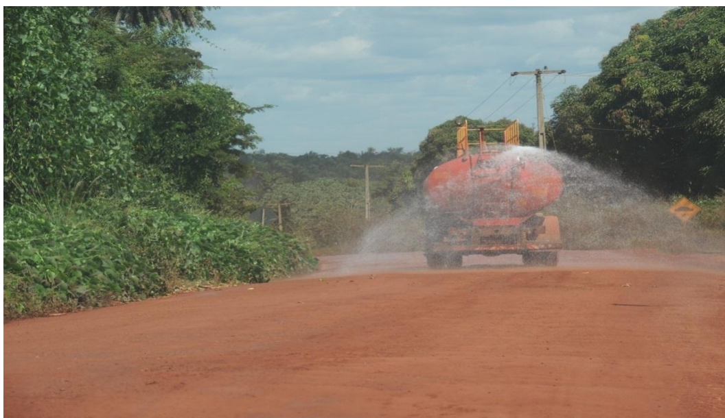
Imagem 6 - Carro pipa molhando a Estrada do Arroz para diminuir a poeira
