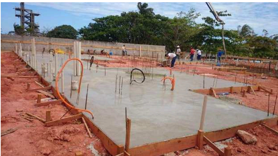
Figura 2 - Fundação em radier
