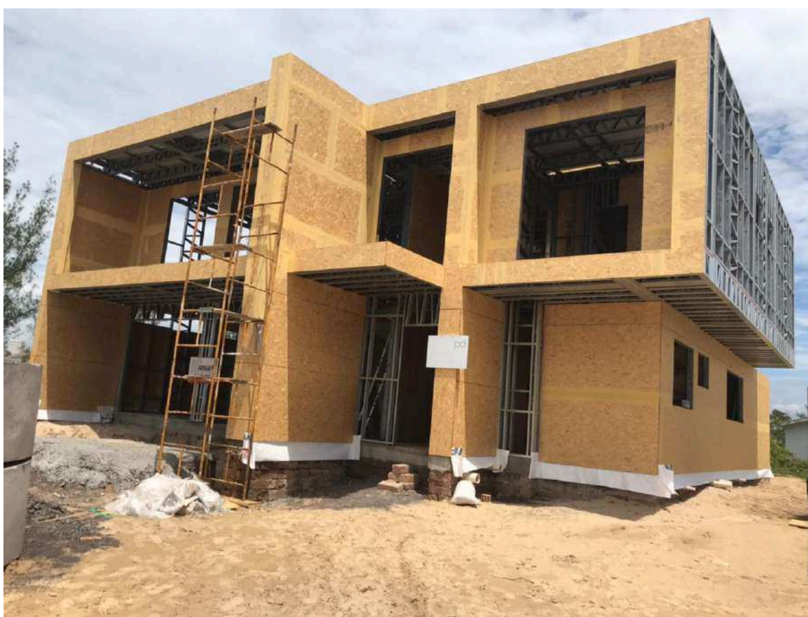
Figura 4 - Vedação externa em OSB em estrutura de LSF
