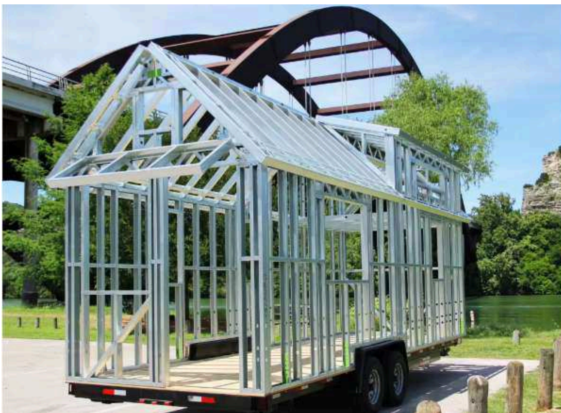
Figura 3 - estrutura de uma tiny house em steelframe.
