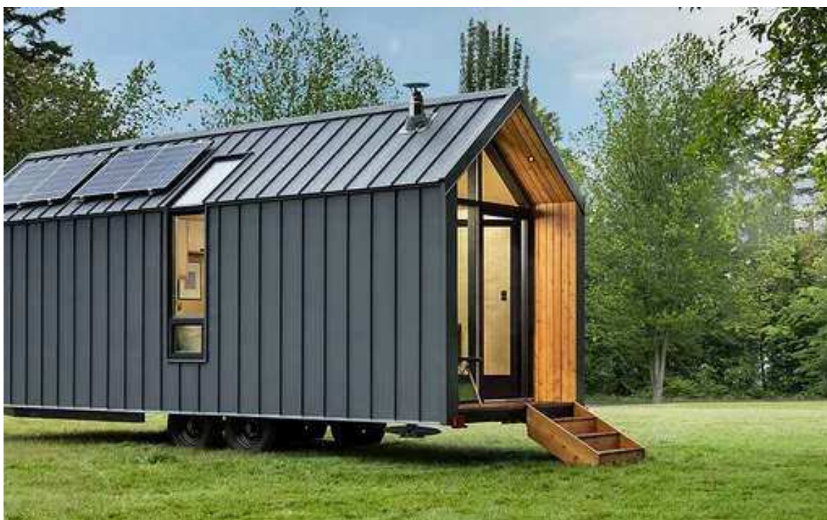
Figura 5 - Tiny house com sistema fotovoltaico.
