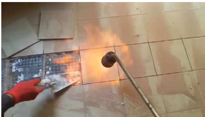
Figura 20: Remoção de revestimento cerâmico, com auxílio de maçarico.
