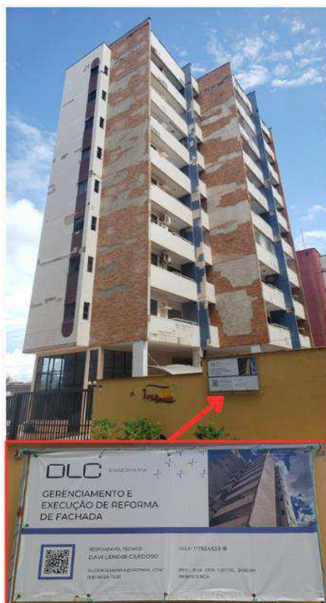
Figura 17: Placa de identificação de prestação de serviço, no Ed. Ana Beatriz. Fonte: Autor, 2024.
