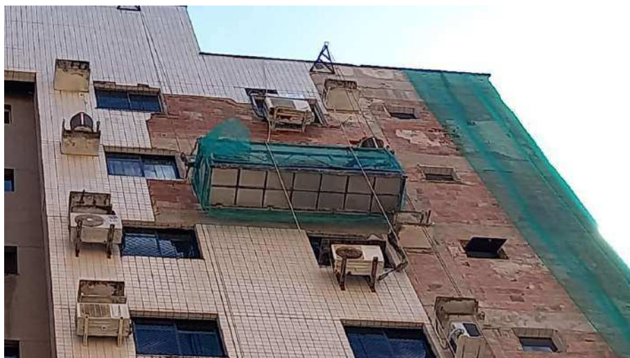
Figura 25: Remoção da camada de revestimento da fachada do Ed. Maison Classic. Fonte: Autor, 2024.
