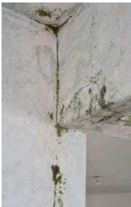
Figura 21: Processo de infiltração no Ed. Maison Classic. Fonte: Autor, 2024.
