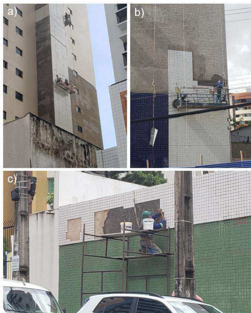
Figura 18: Profissionais trabalhando no restauro de fachadas, com revestimento cerâmico, no bairro Renascença II. Fonte: Autor, 2024.
