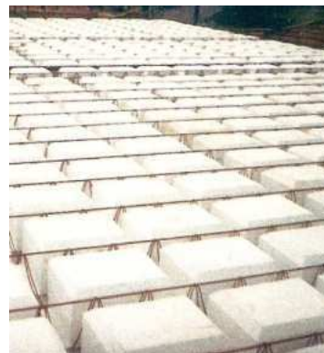
Figura 18 – Lajes bidirecionais (17) Fonte: (GOMES, 2006)
