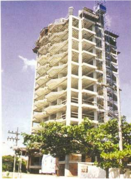
Figura 15 – Lajes treliças Fonte: (GOMES, 2006)
