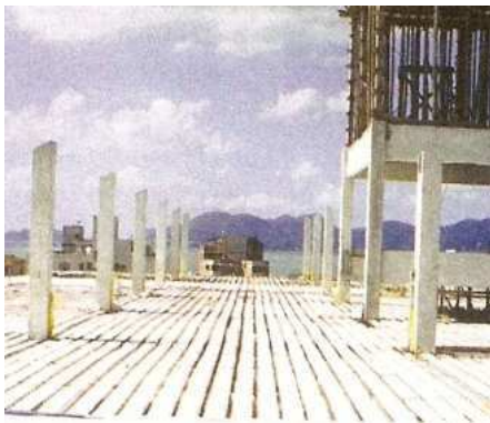
Figura 17 – Lajes unidirecionais (16) Fonte: (GOMES, 2006)
