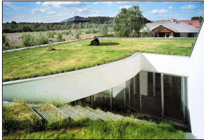
Figura 11. Exemplo de Cobertura Extensiva – Modern OUTrial House. Ksiazynice, Poland. Fonte: Mike Chino/ Inhabitat.com, 2009.
