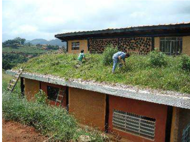
Figura 17. Construção de Telhado Verde em estrutura de Madeira: plantio da Vegetação. Fonte: PlanetaSustentávelAbril.com, 2009.
