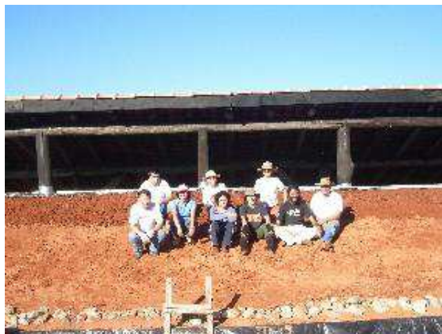
Figura 16. Construção de Telhado Verde em estrutura de Madeira – 2ª e 3ª Etapas. Fonte: PlanetaSustentávelAbril.com, 2009.
