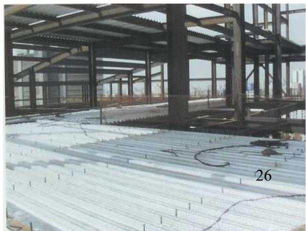
da laje. Atualmente, estão sendo fabricados no país “decks” metálicos de nervuras largas (“wide ribs”) que permitem a instalação de conectores de cisalhamento, do tipo “stud bolts”. Desta maneira as vigas de aço de sustentação da laje podem ser calculada pelo sistema misto. Basicamente, são três os materiais que formam o “steel deck”:
