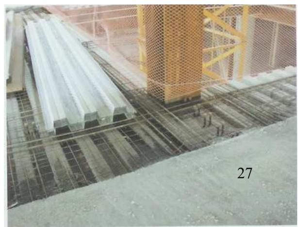
apresenta : largura útil 820mm, espessuras 0,80,0,95 e 1,20 mm, altura da fôrma de aço 75 mm e comprimento variando de 1500 a 12000mm.
