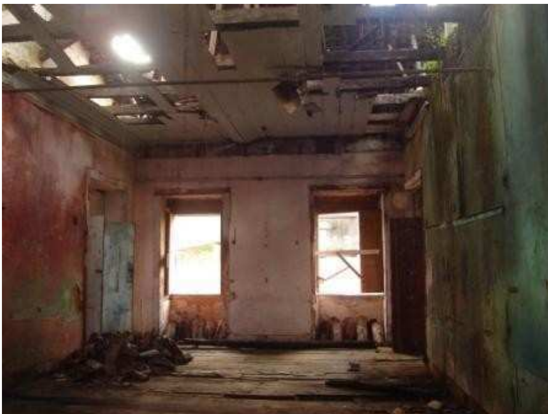
Figura 36: Área do lado direito do 3º pavimento
