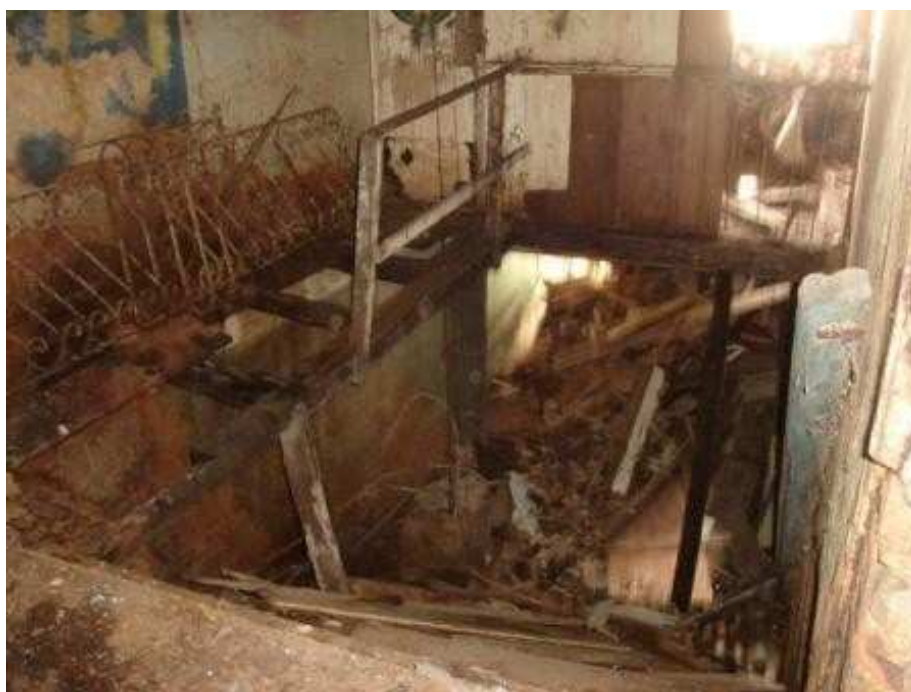
Figura 33: Escada à esquerda do 1º pavimento
