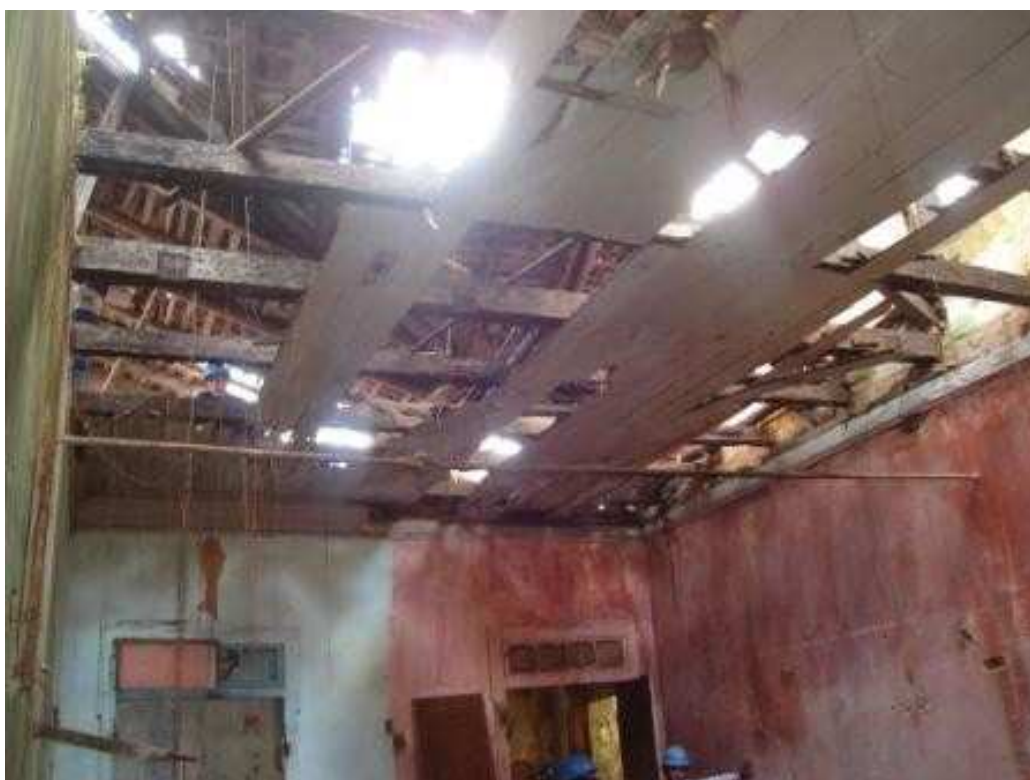
Figura 35: Vista do Tirante no 3º pavimento
