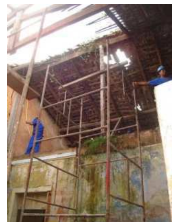
Figura 25 – Detalhe da estrutura do telhado.
