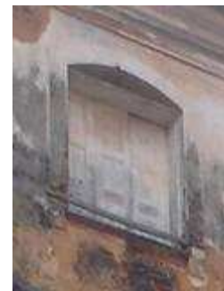
Figura 22 – Detalhe das esquadrias do 4º pavimento
