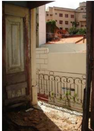
Figura 23 – Detalhe das esquadrias do 3º pavimento
