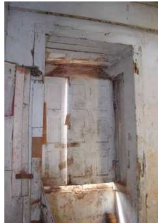
Figura 24 – Detalhe das esquadrias do 3º pavimento
