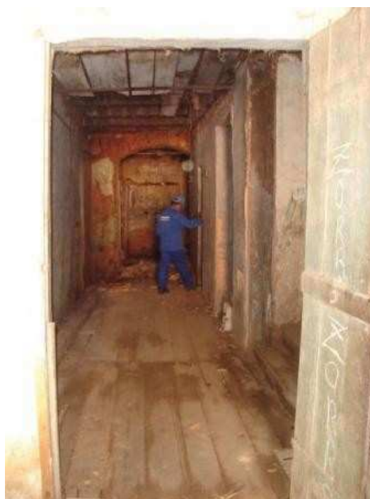
Figura 46: Vista do corredor do fundo do 1º pavimento
