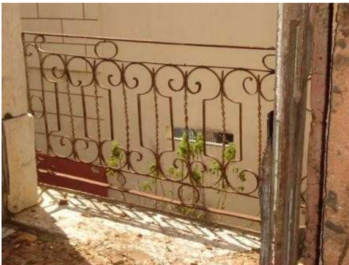
Figura 48: Detalhe do gradil de ferro no 2º pavimento
