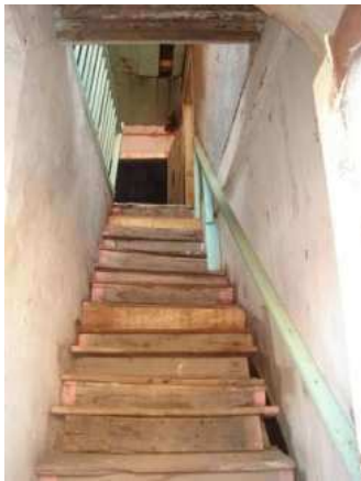
Figura 18 – Escada que dá acesso ao 1º pavimento
