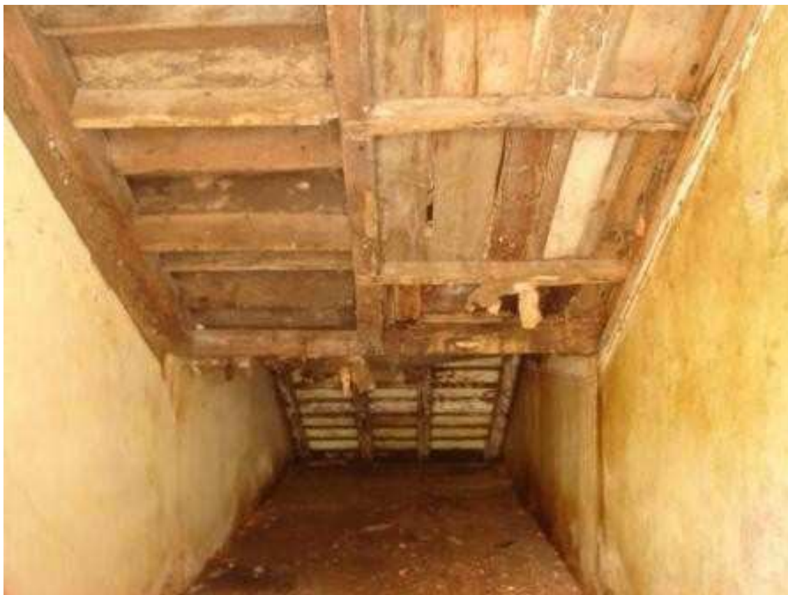
Figura 447: Detalhe da vista abaixo da escada do 2º pavimento
