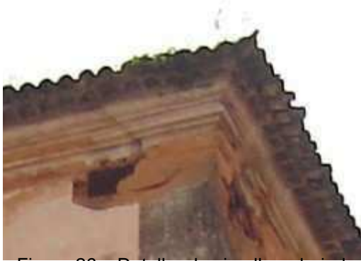
Figura 26 – Detalhe da cimalha e beiral
