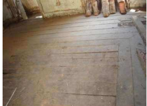
Figura 27 – Detalhe piso do 3º pavimento
