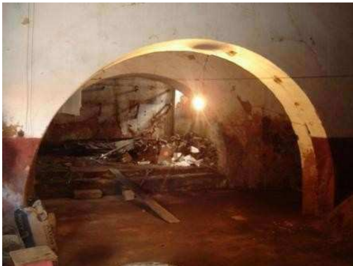
Figura 43: Detalhe do Vão da área a esquerda do pavimento térreo
