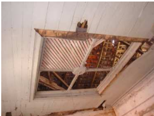
Figura 28 – Forro do 3º pavimento
