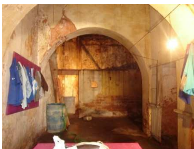
Figura 45: Detalhe da área a esquerda do pavimento térreo
