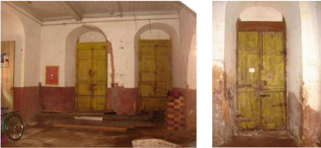
Figura 20 – Detalhe das esquadrias do pavimento térreo.
