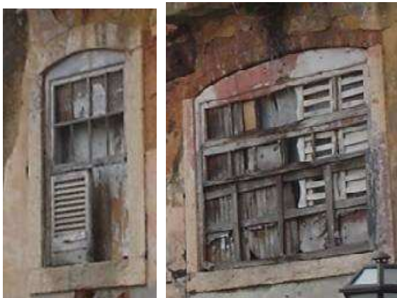
Figura 21 – Detalhe das esquadrias do 2º pavimento
