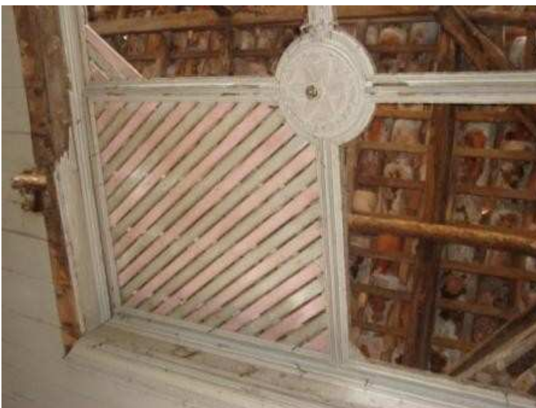
Figura 37: Forro do lado direito do 3º pavimento
