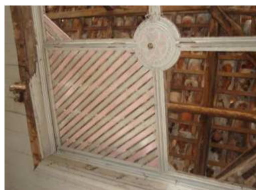
Figura 29 – Detalhe forro do 3º pavimento
