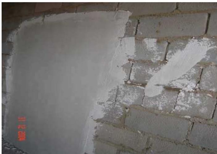
Figura 5 – Revestimento interno com gesso
