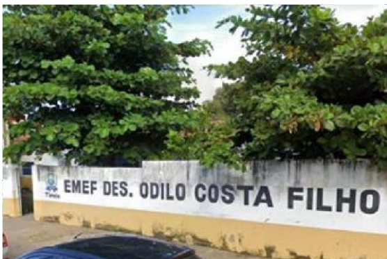
Foto1: Fachada da Escola
