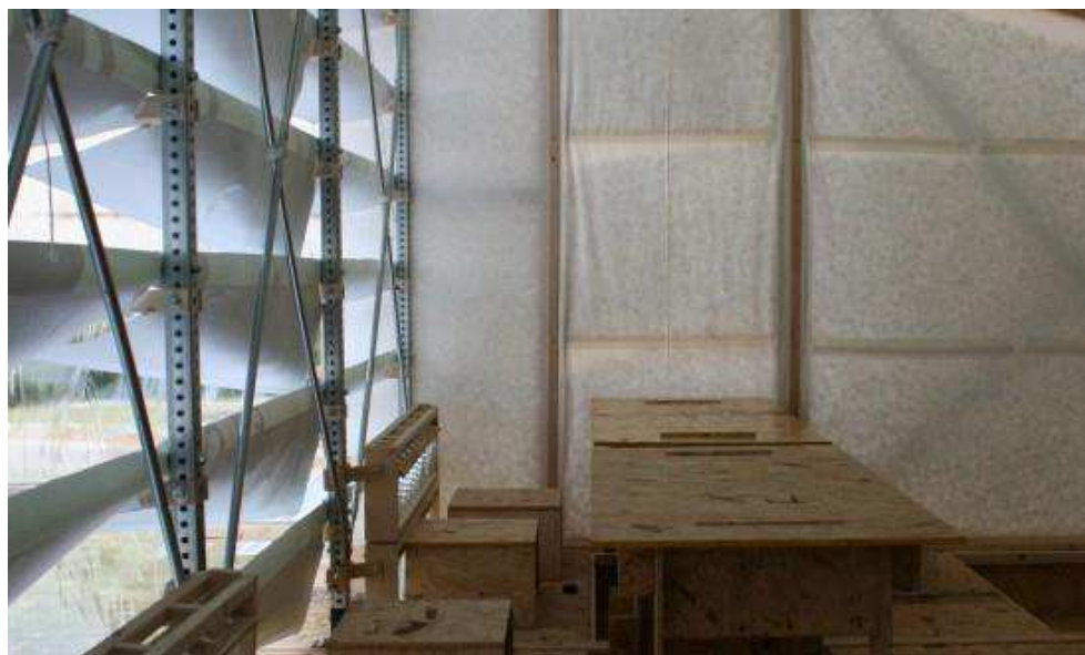
Figura 21: Visão interna da 4:10 House, com peças metálicas, isolamento térmico e móveis de OSB.
