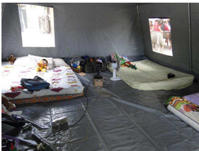
Figura 35: Interior dos abrigos emergenciais. Detalhe para as estrutura de ferro, chão de lona e aberturas na lateral e face posterior.
