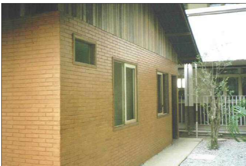
Figura 4 - Habitação popular construída com a técnica solo-cimento.
