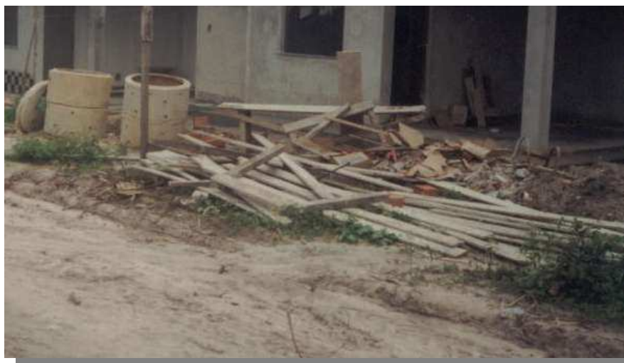
Figura 26 - Restos de Materiais de Construção
