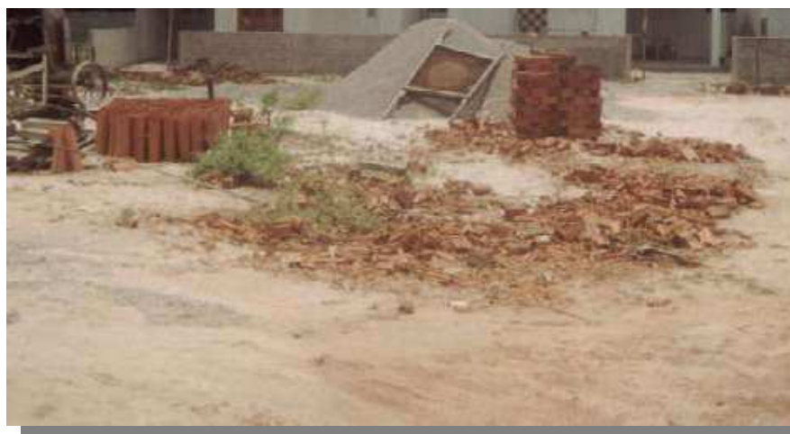
Figura 27 - Restos de materiais de Atividades Construtivas
