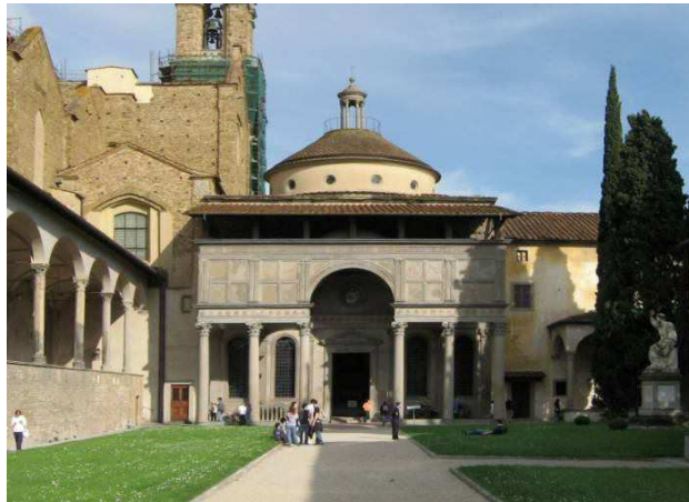
Figura 13 – Capela Pazzi, Florença – Fachada Fonte: http://www.arch.mcgill.ca
